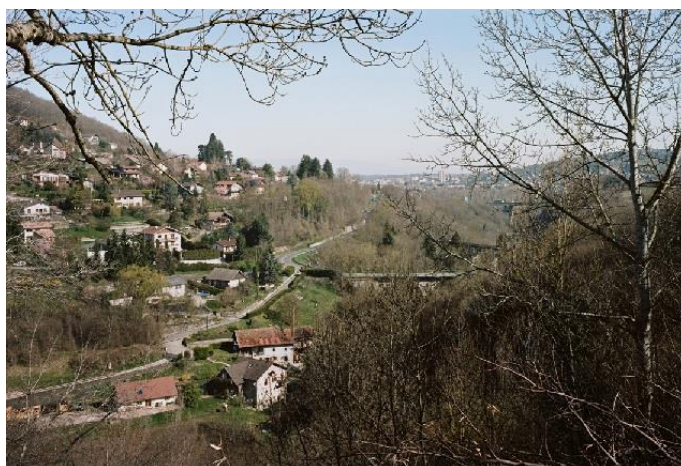
Viaduc du Viaison, Reignier-Essery
