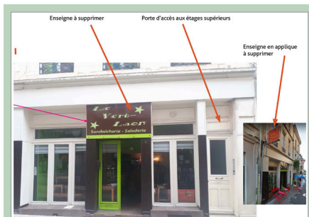
état initial - commerce à LAON
