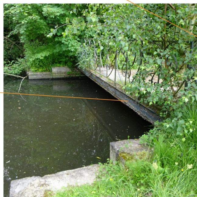
Pont en poutre métallique et tablier en béton : système à repenser
