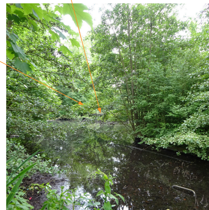
Le pont a disparu et permettait l'accès à une île
