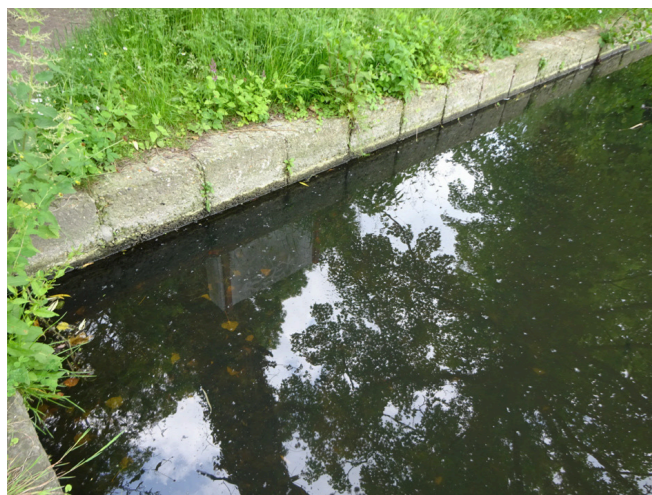
Margelle cimentée
