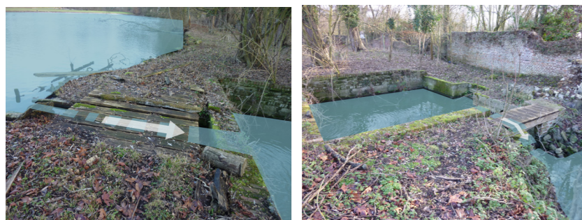
Fonctionnement de l'exutoire
