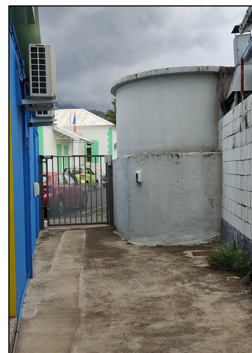
Entrée étroite, exposée au soleil et à la pluie, bétonnée et non valorisée
