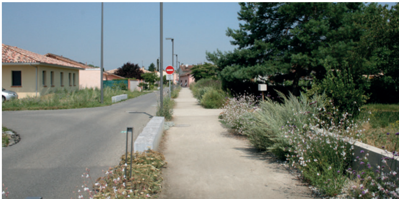
■ Grisolles : l'aménagement propose une nouvelle lecture du tissu urbain, grâce, entre autres, à une qualification des limites.
