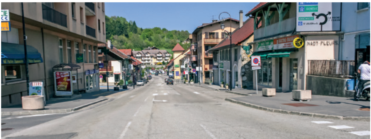
Photo de la Grand'Rue avant aménagement.
