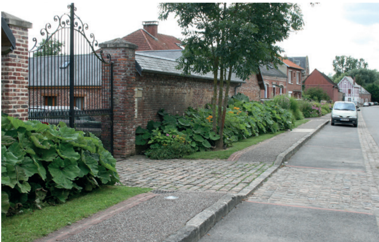
Ribemont-sur-Ancre : le végétal donne un cadre à la rue tout en rappelant la végétation du marais proche. Il permet aussi d'annoncer l'entrée d'un équipement ou d'un bâtiment important.
