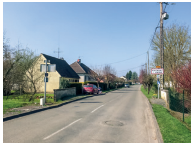
Entrée sud de la commune peu marquée (avant aménagement).
