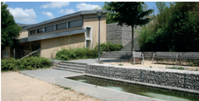
L'espace en contrebas a été conçu comme un espace calme, avec bancs et fontaine. Cette résurgence d'eau a été découverte lors du chantier et transformée en élément de projet.
