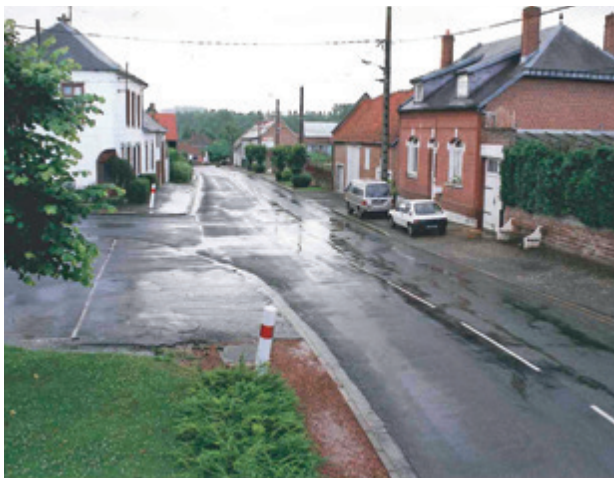
Vue depuis le haut de la rue des Celtes (avant aménagement).
