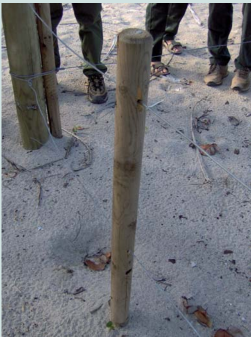
Poteaux en pin traité, avec percements pour passage des fils
