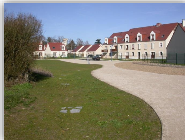
Uniformité des revêtements, légère pente pour l'évacuation des eaux pluviales vers une bande herbeuse
