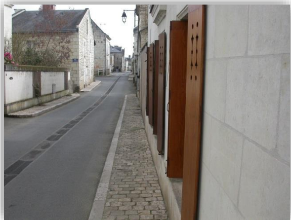
Un unique caniveau central, bitume coulé jusqu'à la bordure
