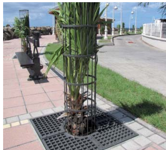
dispositif de protection d'arbre de qualité mais mal adapté à la taille des plantations (Basse-Terre)
