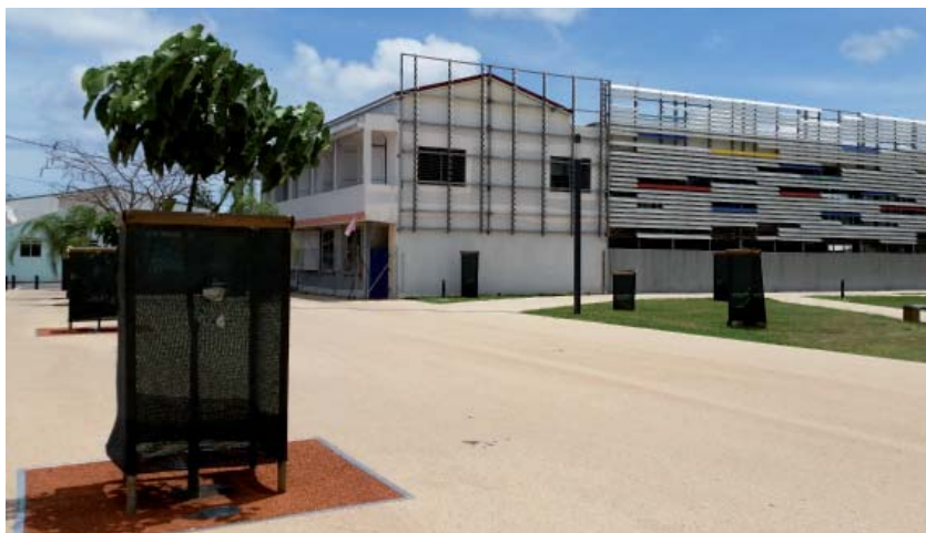
tuteurage quadripode, toile ombrière et revêtement de sol perméable lors de nouvelles plantations sur le boulevard maritime de Port-Louis
