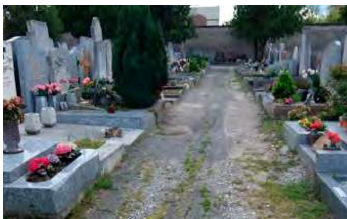
3 - Cimetière de Loyasse à Lyon (69). Cette allée, dont l'enrobé vieillit avec des fissures où poussent des adventices, où creux et bosses gênent la circulation piétonne et créent des flaques après la pluie, sera réhabilitée en ménageant deux bandes enherbées de 50 cm (passage de la tondeuse) le long des sépultures et une bande en béton au centre. © P&C - Sandrine LARRAMENDY 2016
