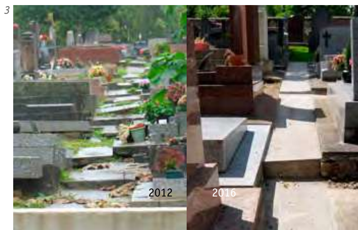
3 - En 2012, les semelles des monuments, non planes et non jointives, ne permettent pas de circuler avec sécurité dans certaines allées secondaires. 4 - En 2016, un travail de reprise des semelles et de création de cheminement en béton a été mené. Cimetière des Gonards à Versailles (78) © P&C - Sandrine LARRAMENDY 2016
