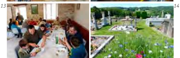
9 - Le cimetière de Saint-Bonnet-les-Tours-de-Merle (19), 50 hab, en 2014, avant les travaux. 10 - Le jour de l'inauguration le 31 octobre 2015. - 11 - 12 - 13 - Pendant les travaux menés bénévolement, au mois de mars 2015, par près de la moitié des habitants. 1 - En 2016. © Jean-Michel TEULIERE - Voir www.xaintrie-passions.com/rénovation-cimetière-saint-bonnet/
