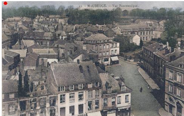
Vue aérienne - Place de la Nation
