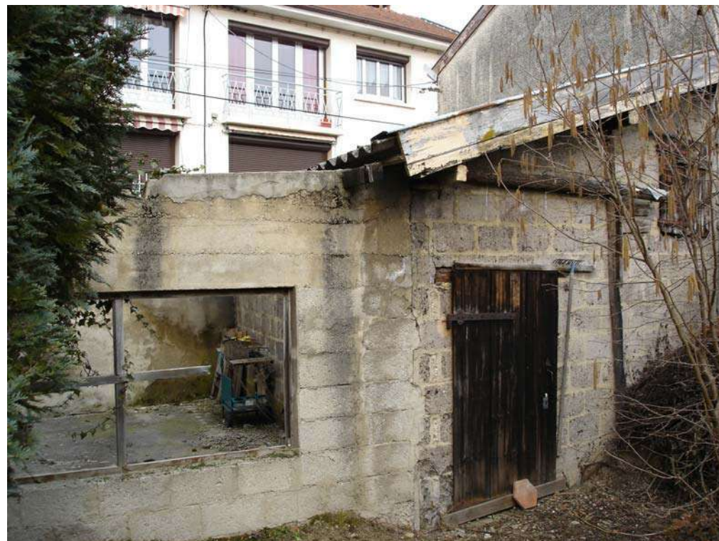
Vue du bâtiment à démolir sur le terrain qui ne présente pas de caractère architectural intéressant
