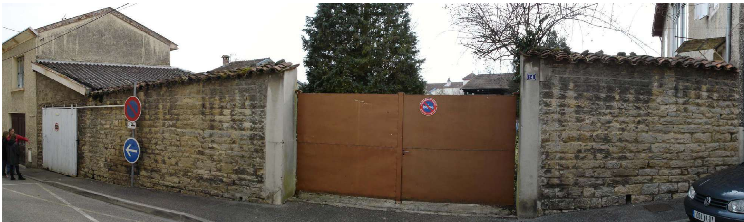
Rue Charles Guillon, la parcelle se trouve derrière le mur en pierre qu'il est prévu de conserver dans le projet
