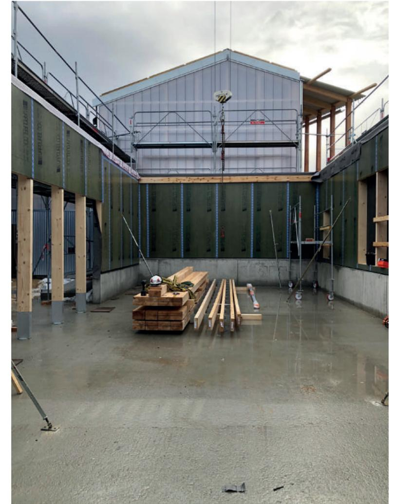
Mise en oeuvre sur chantier des pièces découpées sur place
