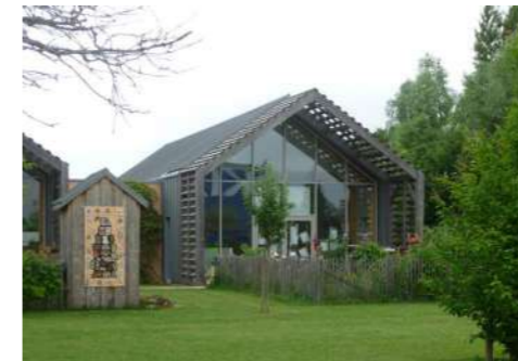
Ecole maternelle de Saint-Denis-les-Ponts (28) Bardage, bois, ossature bois Année : 2010, Surface : 700 m 2 Coût : 1 380 000 € ht
