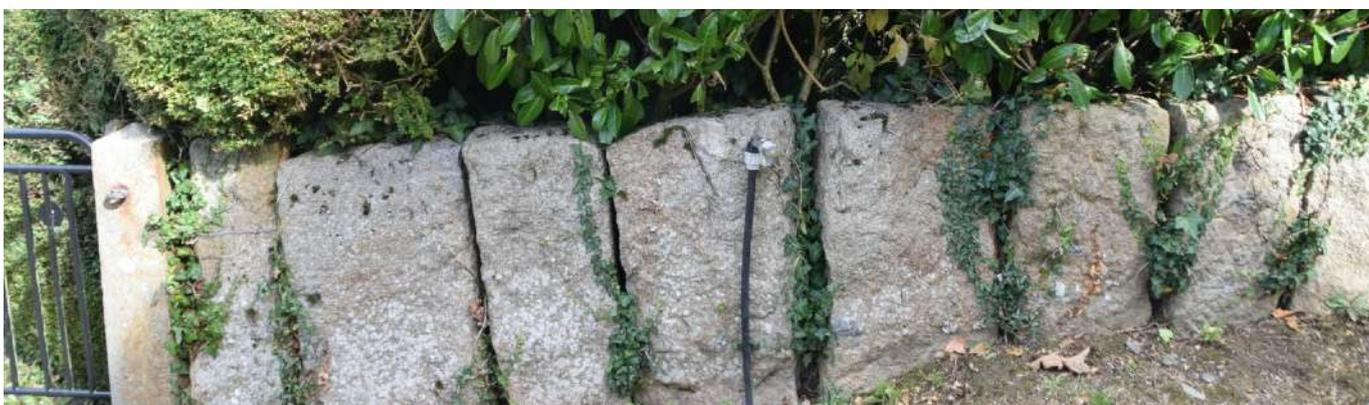
Clôture du cimetière en blocs de taille de granite, pose verticale.
