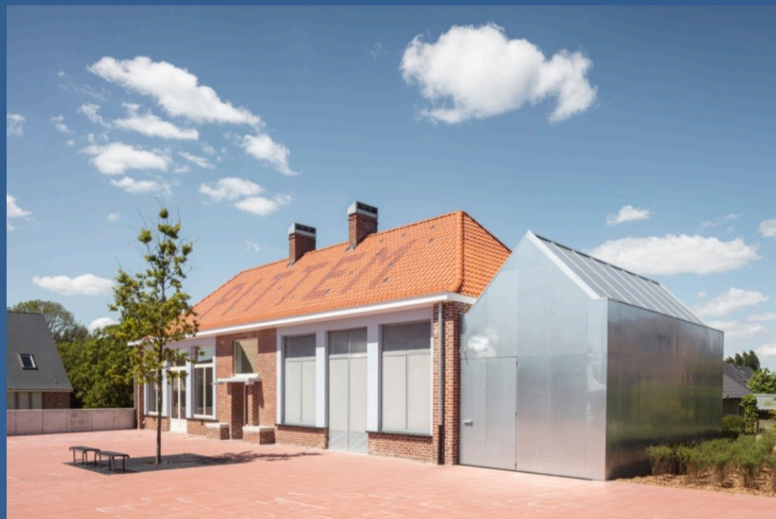
SW1504 – Le site de Eikeldreef à Pittem Debardeur
