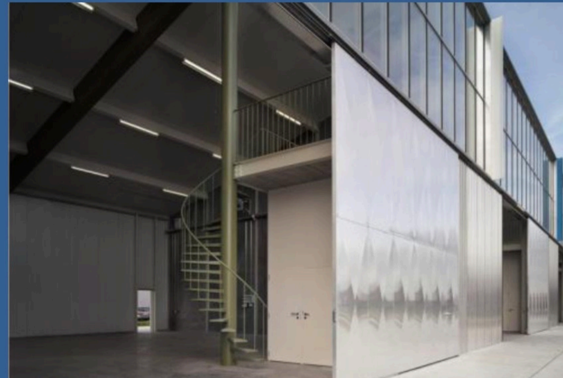
OW1304 - Incubateur d'entreprises à Waregem Office Kersten Geers David van Severen
