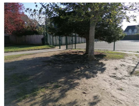
Sol perméable de pleine terre et pelouse dégradée
