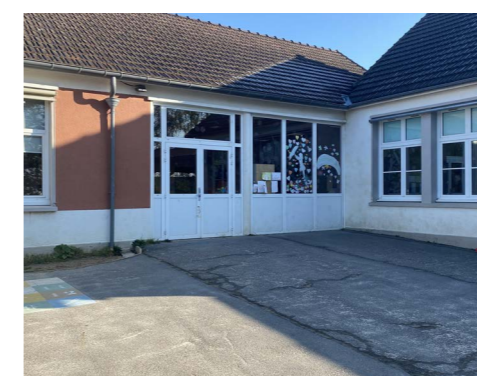
Accès à la cour depuis l'espace primaire
