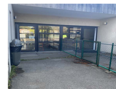
Accès au hall des sections primaire et maternelle
