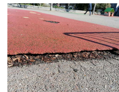
Jonction entre les différents matériaux
