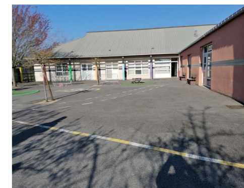
Sol de la cour exclusivement imperméable
