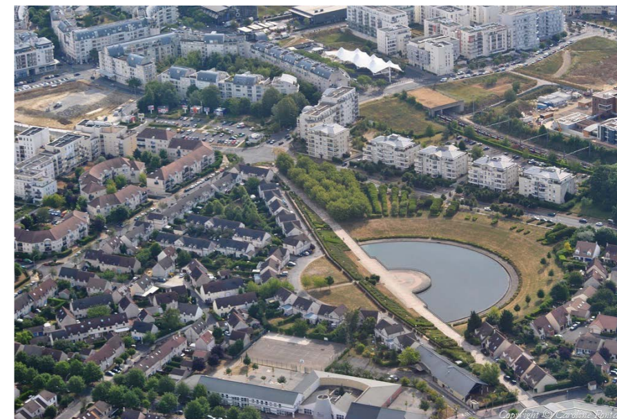
Vue aérienne de Courdimanche (quartier de la Louvière)
