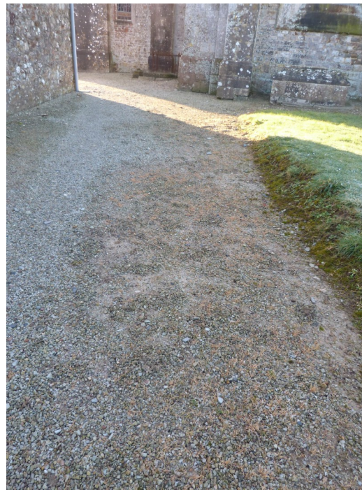
Allée nord, nord-est : traces de traitements chimiques
