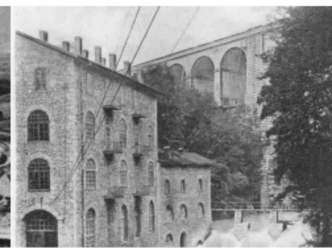
Bellegarde, Usine électrique et viaduc, Archives Départementales
