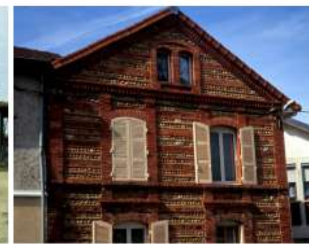
Le carron, matériaux typique de la Dombes, résiste au choc et au gel
