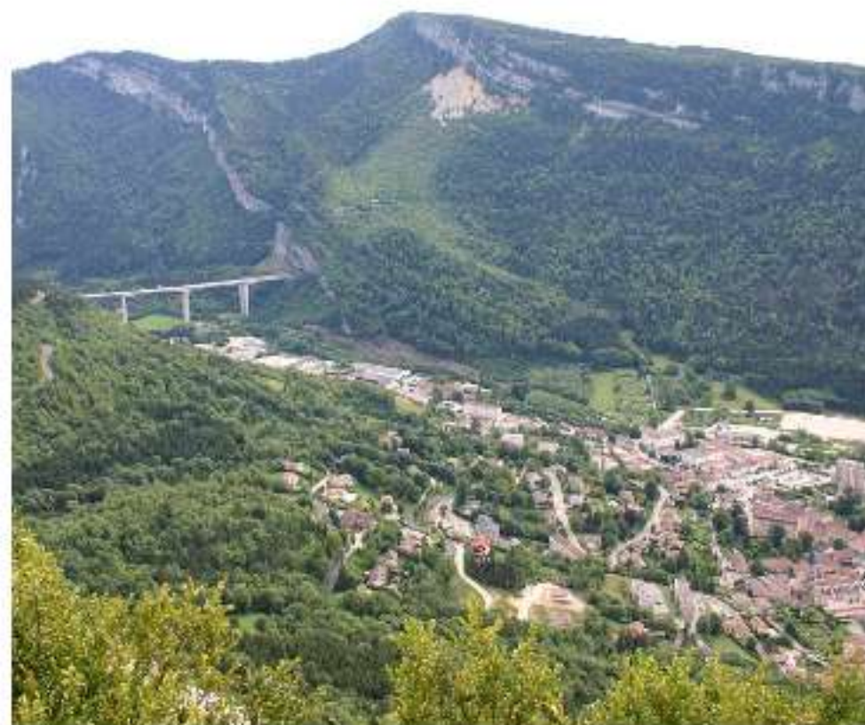
"voir et être vu" Le viaduc de l'A40 (autoroute des Titans - 1990) surmontant Nantua
