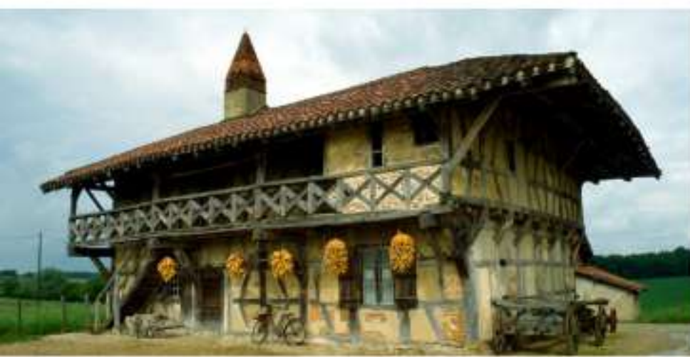
Les débords de toits protègent les murs de la pluie
