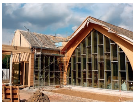
Filère bois Locale: médiathèque de Givenchy-en-Gohelle Elsa Liverani architecte
