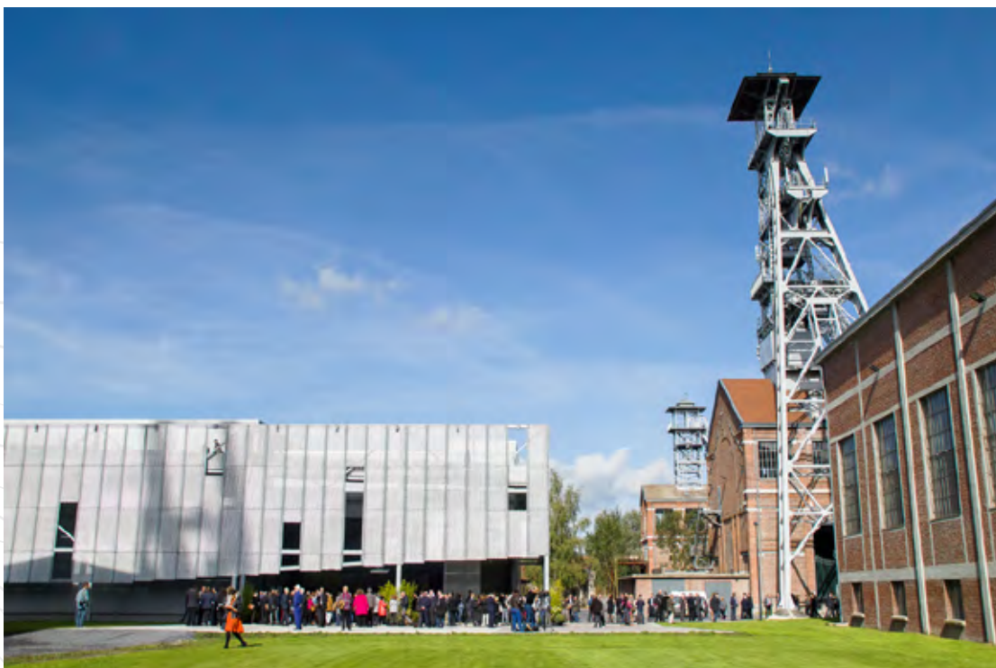
Vue du site Creative Mine sur le site d'Arenberg Bouygues Bâtiment NE - JN Chene
