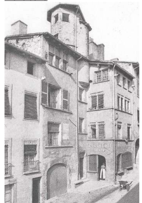
Carte postale des années 1950 montrant persiennes et jalousies sur la rue du Port à Trévoux (01) - © DR.
