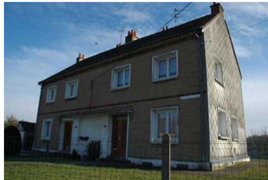
Cité Lyautey, partie ancienne, Barlin
