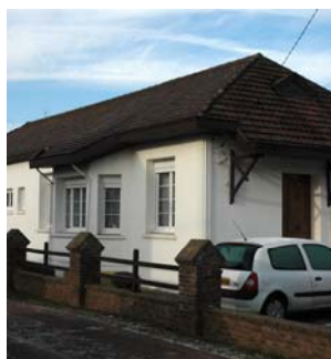
Maison de garde-barrière, Cité Jeanne d'Arc, Barlin
