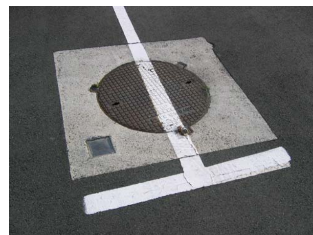
Dalle du puits 4 bis à Hersin.
