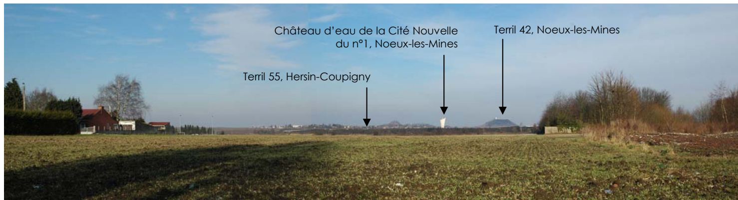
Depuis la RD 188, entre Sains-en-Gohelle et Hersin-Coupigny
