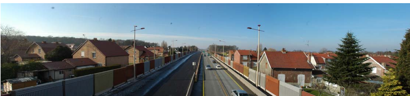
RD 301 et murs antibruit à hersin-Coupigny, séparant
