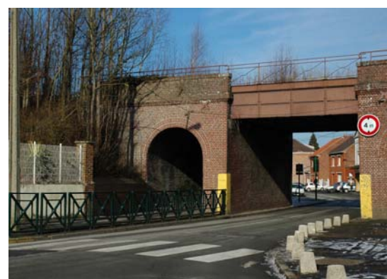
Pont de l'ancienne ligne de voyageurs Bully-Brias, Rue Emile Zola à Hersin
