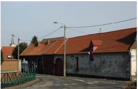
Ancienne ferme Rue Lavoisier, Hersin
