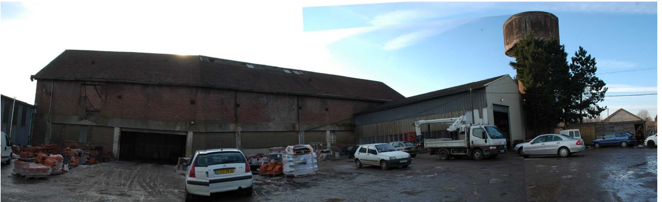
Salle des machines de l'ancienne Fosse 5, Barlin
