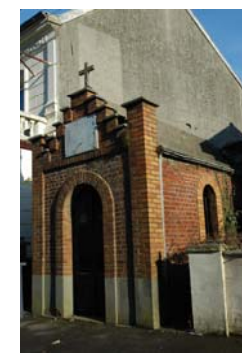
Chapelle, Rue de Fresnicourt, Barlin
