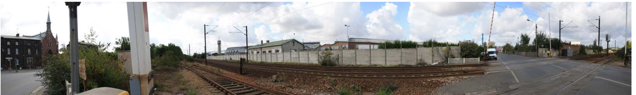
Au niveau de la voie ferrée entre l'usine et la cité Asturienne
