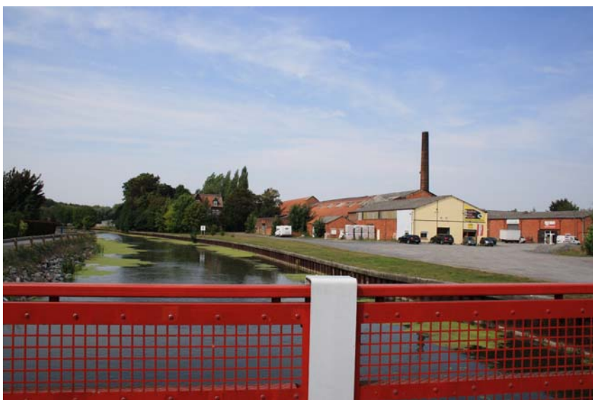
Cheminée de la briqueterie de Râches
