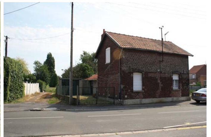
Maison de garde barrière rue Emile Zola
