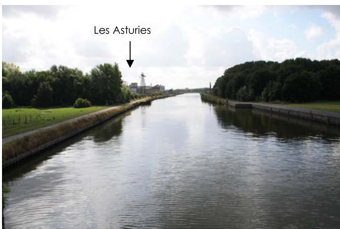
Pont au dessus du canal de la Scarpe à la Deûle
