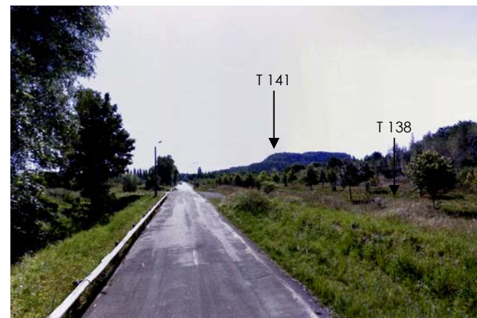
Vue depuis la longue digue au niveau de la fosse 9
