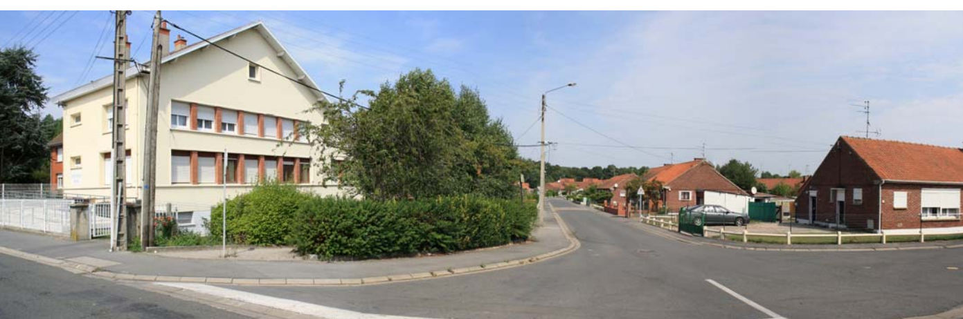
Vue sur le SSM à proximité de la cité des Vanneaux
