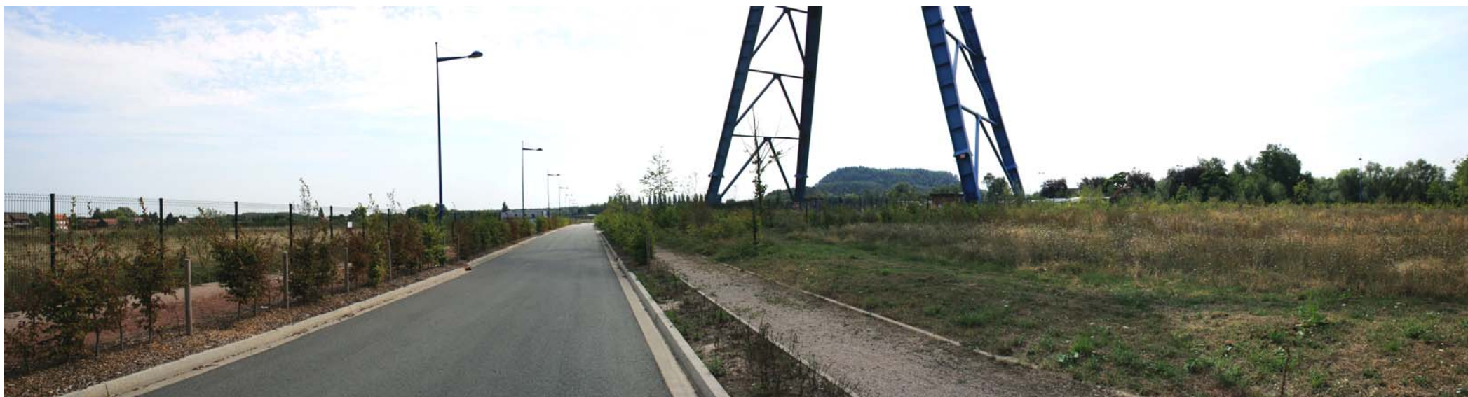
Ancienne fosse 9 et son chevalement, future zone d'activités du chevalement
