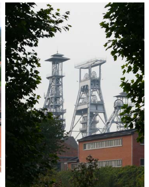
Les chevalements éléments repères de l'EPMR
