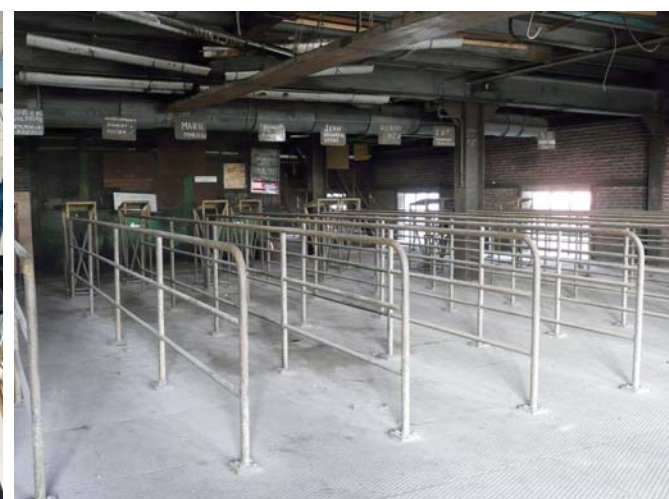
Intérieur du chevalements n°3, lieu de rassemblement avant la descente
