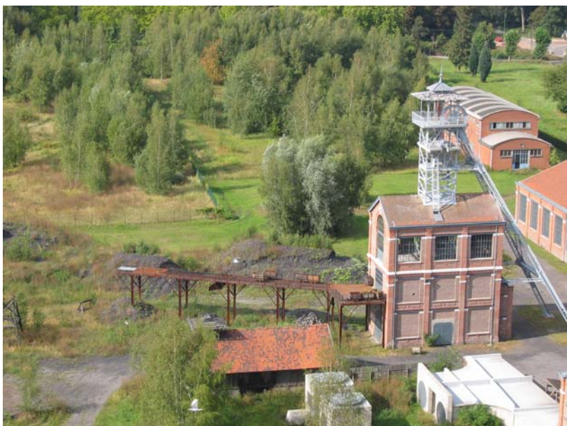
Vers la mise à terril du puits n°1 depuis le chevalement n°3
