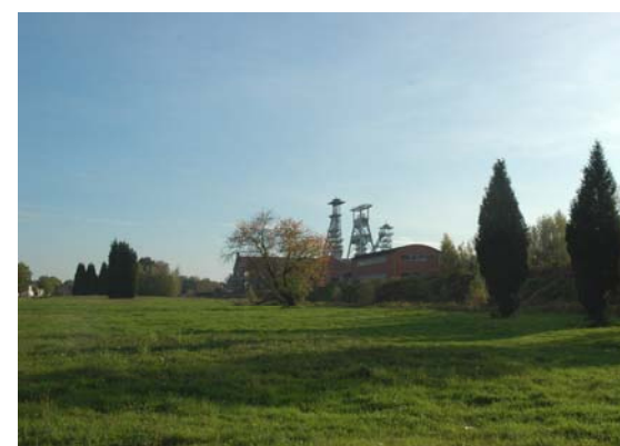
Emplacement d'anciennes maisons de la Cité d'Arenberg
