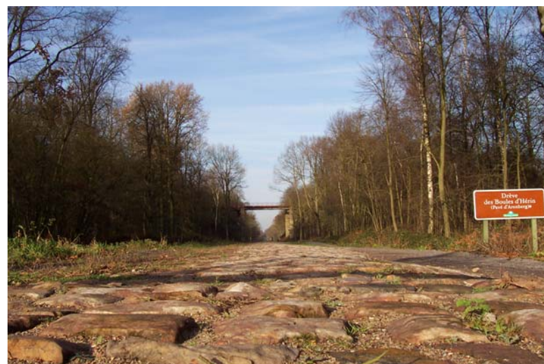
Pont ferroviaire au dessus de la drève des boules d'Hérin
