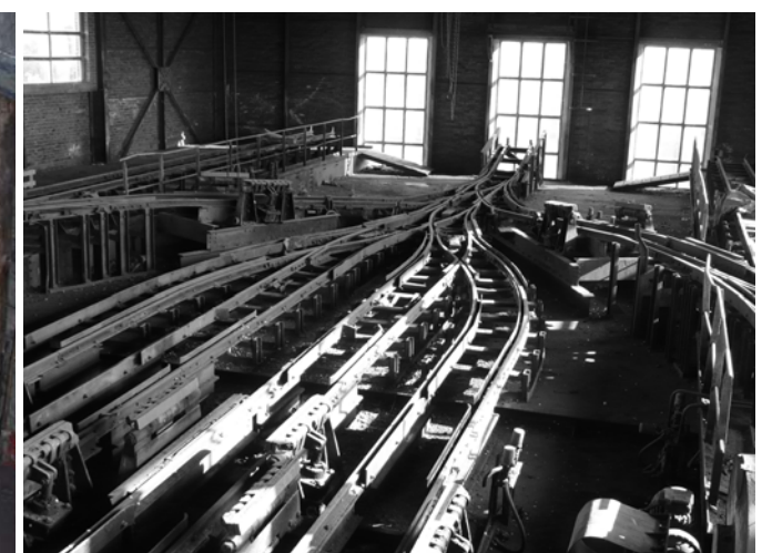
Intérieur du chevalement n°3 système de rails à proximité de la cage d'extraction
