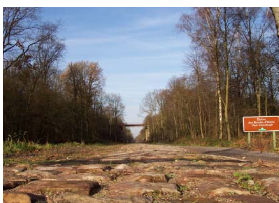
Pont ferroviaire au dessus de la drève des boules d'Hérin
