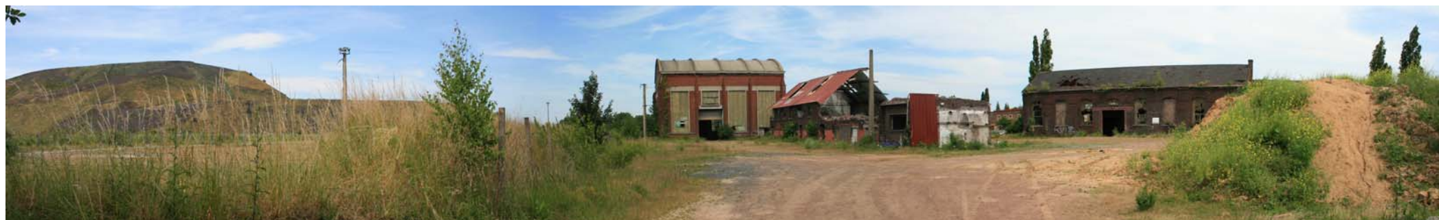
Ancienne fosse la Parisienne en Juin 2009, ne reste plus qu'actuellement le bâtiment d'extraction
