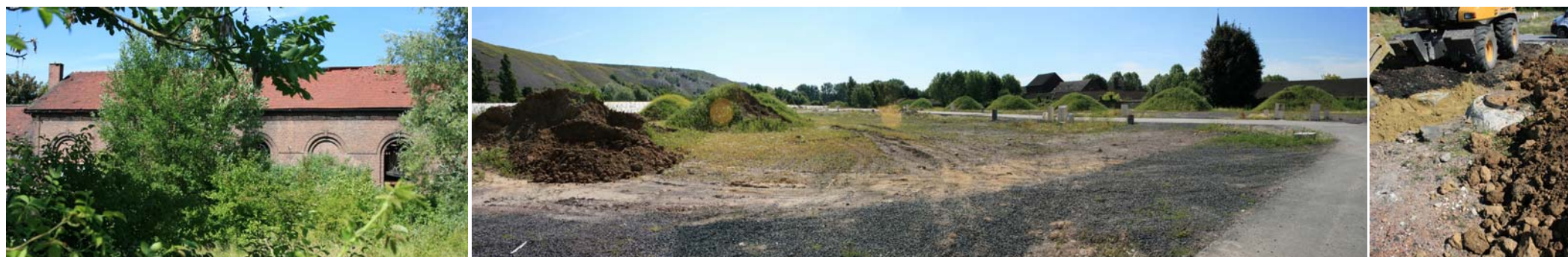
Ancienne fosse 2 de Rouvroy, quelques bâtiments, emprise en projet de construction d'un lotissement, le puits se retrouvant au milieu d'un rond point.
