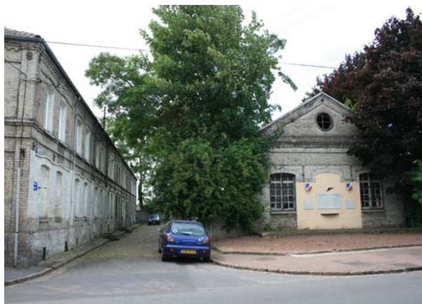
Ancienne fosse 3 ou mulot, reste entrée, bureaux et emprise
