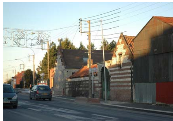
Ancienne ferme Rue Nationale
