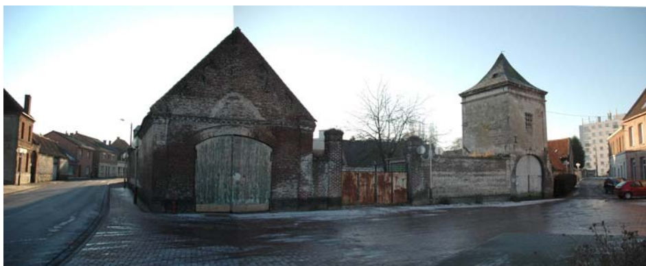
Ancienne ferme avec pigeonnier-proche, Place de l'Eglise (Rue St-Nicolas)
