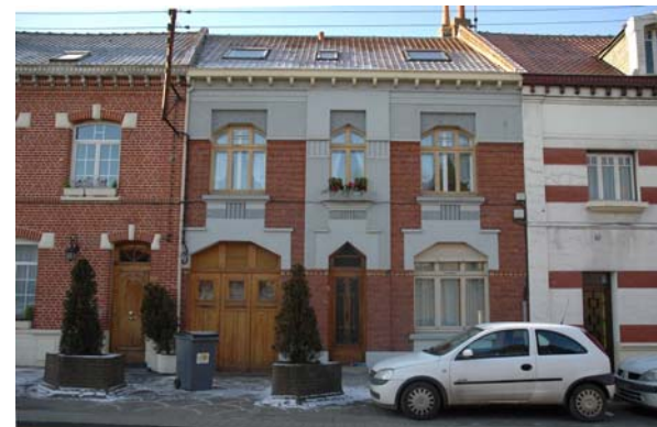
Habitation à la façade Art Deco, Rue Nationale/RD 937
