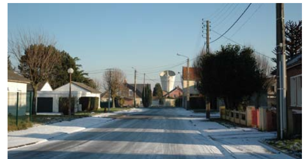
Le Château d'eau de la Cité Nouvelle du n°1, dans l'axe de la rue du Mal Joffre
