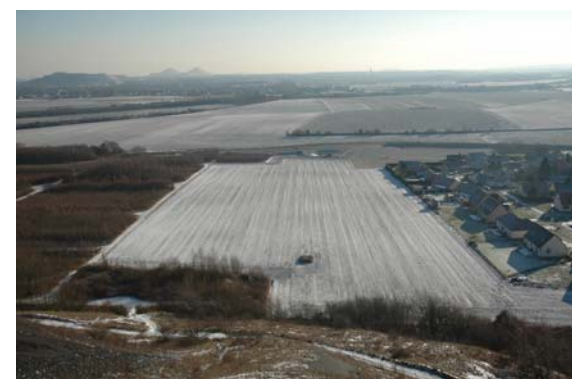
Massif béton d'un pilier de l'ancien téléphérique en plein champ
