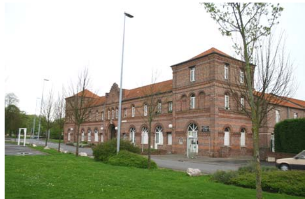
Anciennes écuries du Sana (logements sociaux)
