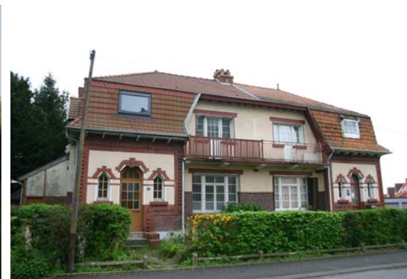
Presbytère polonais, cité de Montigny
