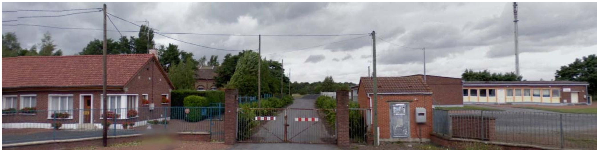
Entrée de la fosse Barrois
