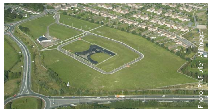
Vue aérienne de la fosse De Sessevale
