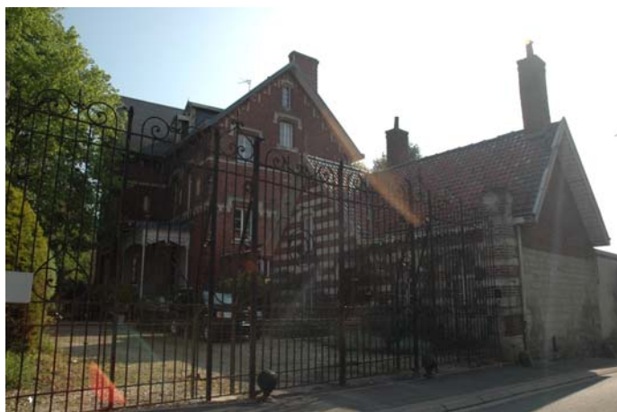
Maisons de maîtres dans les hauteurs de Montigny en Ostrevent
