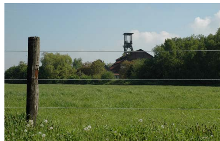
Le chevalement béton de la fosse 2 de Flines
