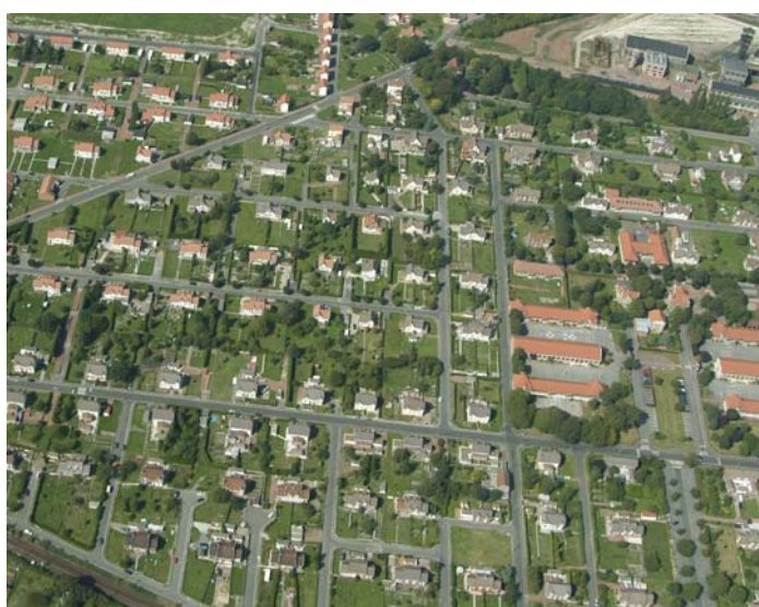
Tissu urbain aéré de cité pavillonnaire composé de maisons jumelées
