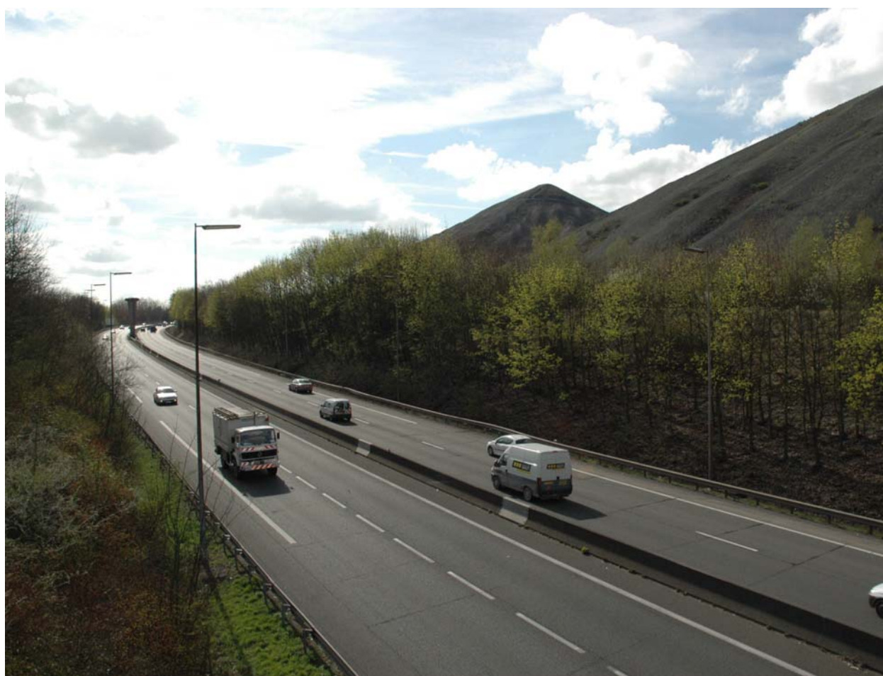
Loos-en-Gohelle, pilier d'un ancien pont au-dessus de l'A21
