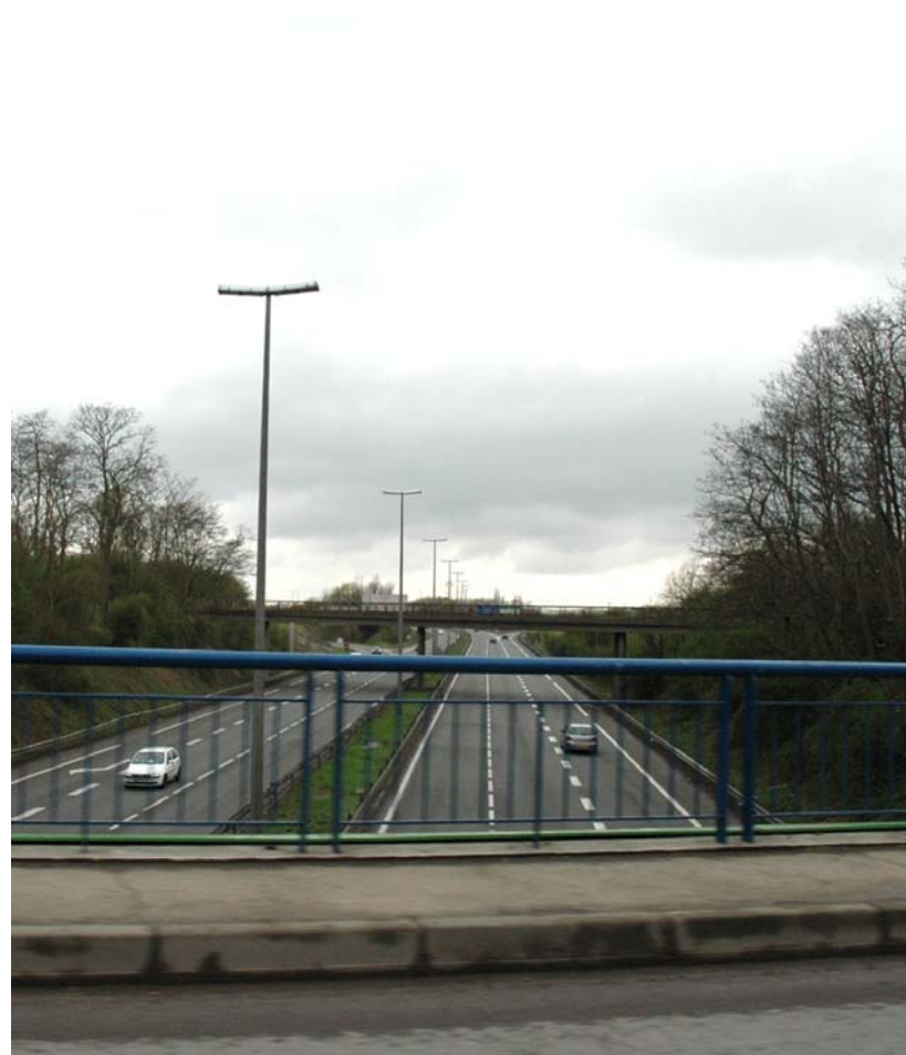
Lens, pont ferroviaire désaffecté au-dessus de l'A21
