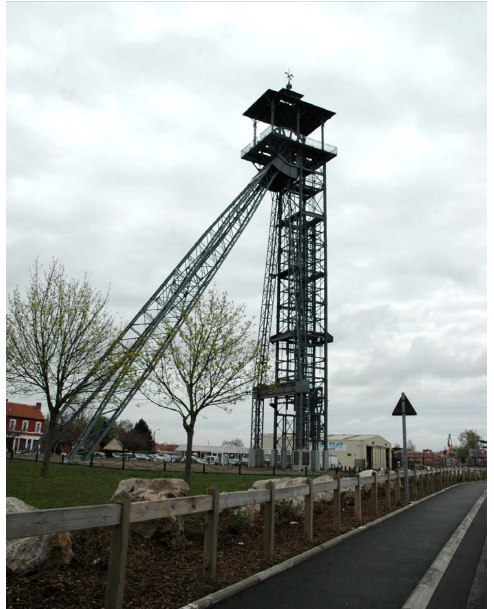
Liévin, Chevalement de l'ancienne Fosse Aimé Tilloy (puits n°3).
