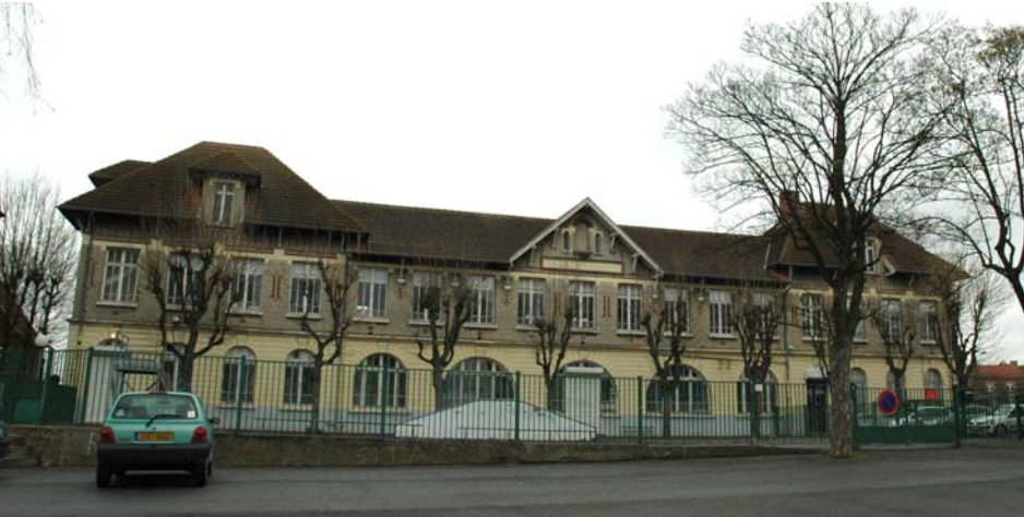
Liévin, école Léo Lagrange, Cité du n°3
