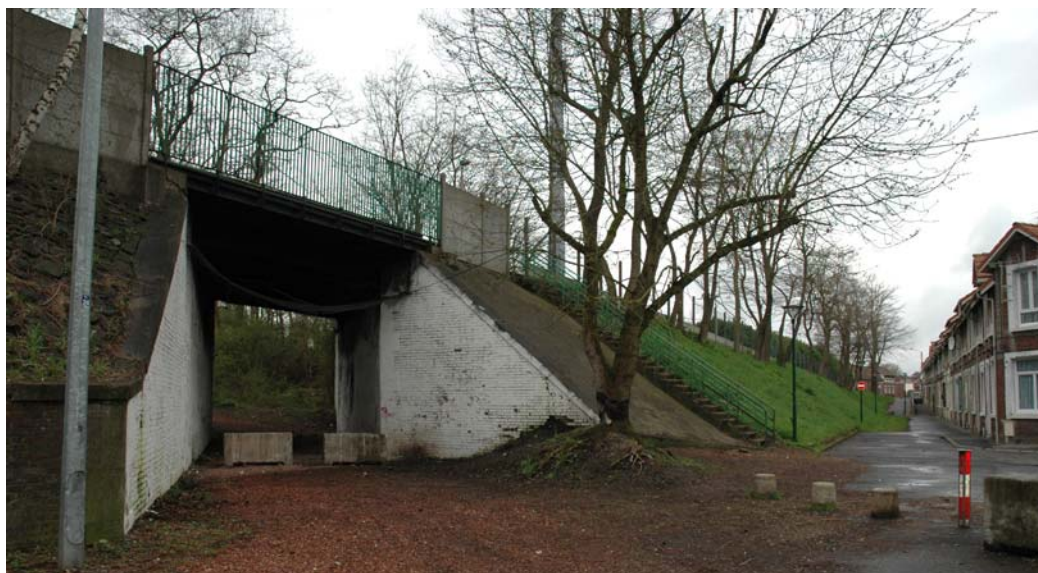
Lens, passage sous pont aux abords de l'ancienne Fosse 9
