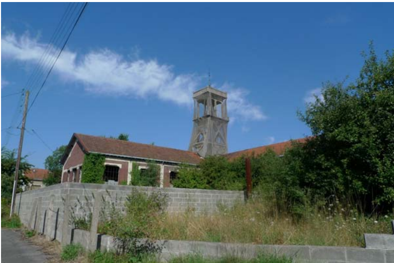
Douvrin, ancienne Fosse 6 et son chevalement
