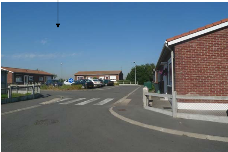
Logements modernes d'origine
