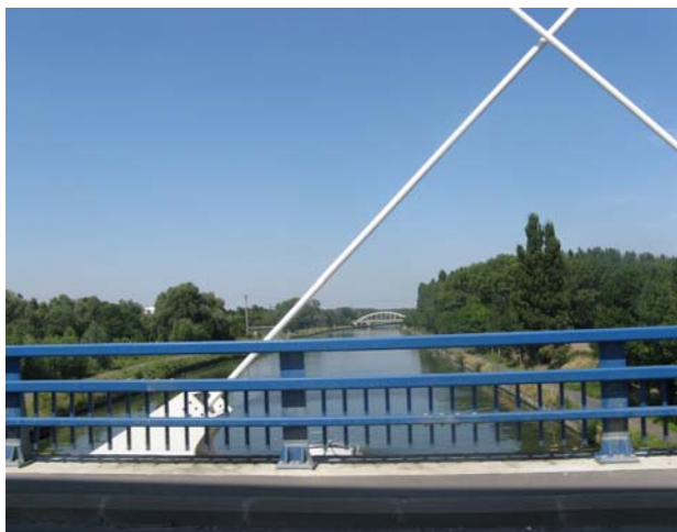
Pont sur la Deule (au niveau de la D 165)
