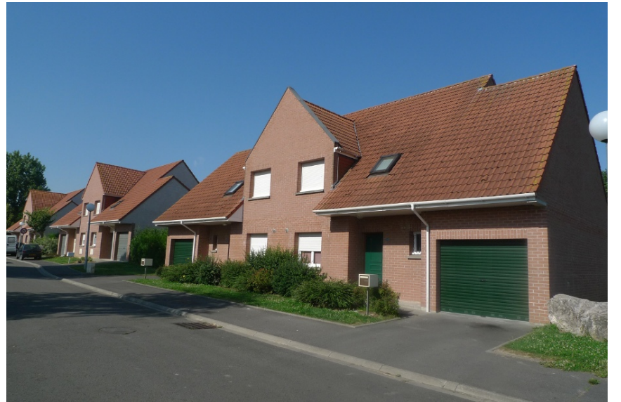
Nouveaux logements 1995, remplaçant des « Camus » démolis
