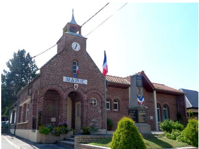
Mairie de Benifontaine
