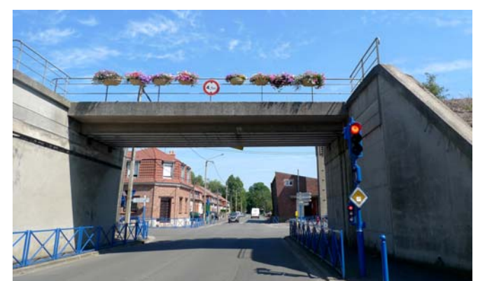
Pont ferroviaire, cité du Pont
