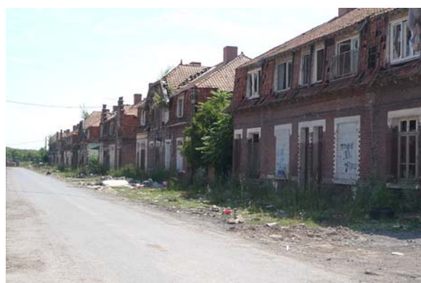
Rue en reconstruction
