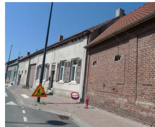
Habitations à Hulluch
