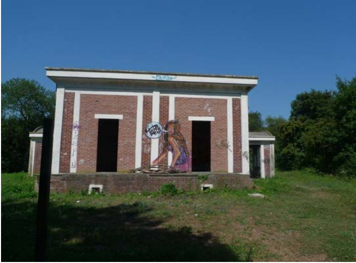
Hulluch, ancienne Fosse 13 bis et son chevalement en béton
