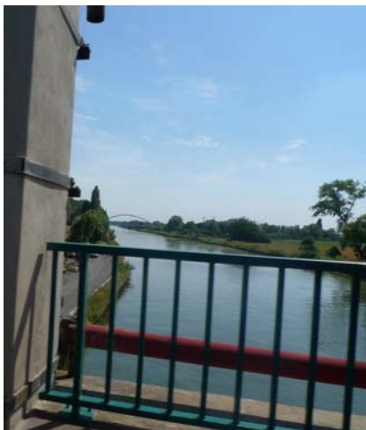
Pont sur la Deule (au niveau de la cité du Pont)
