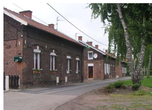
Corons de la Cité Chabaud Latour ancienne
