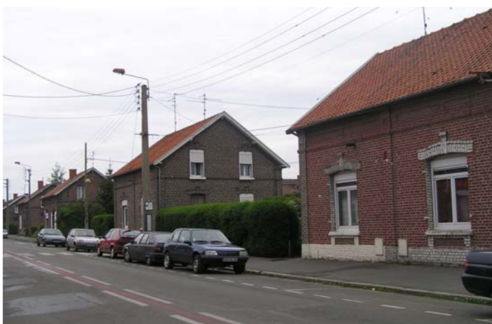
Cité pavillonnaire Chabaud Latour nouvelle
