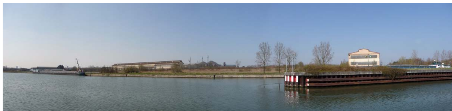
Gare d'eau en bordure de l'Escaut
