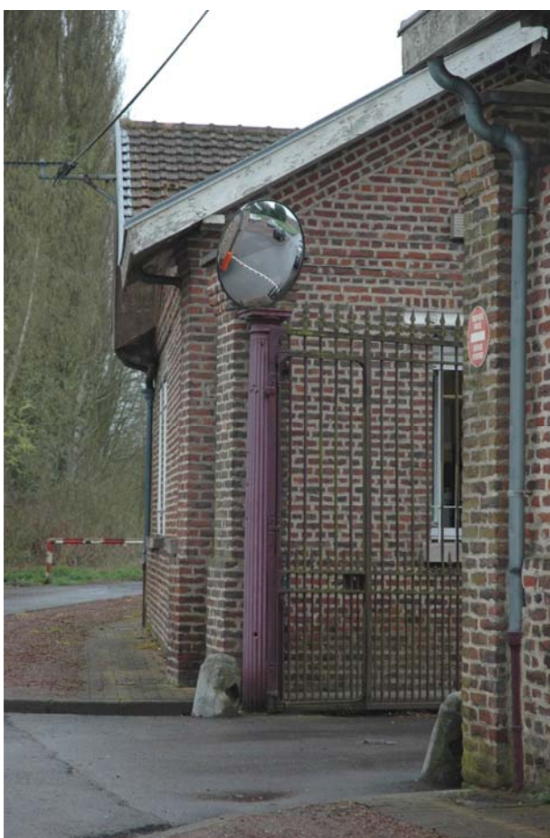
Ancienne fosse Sout
