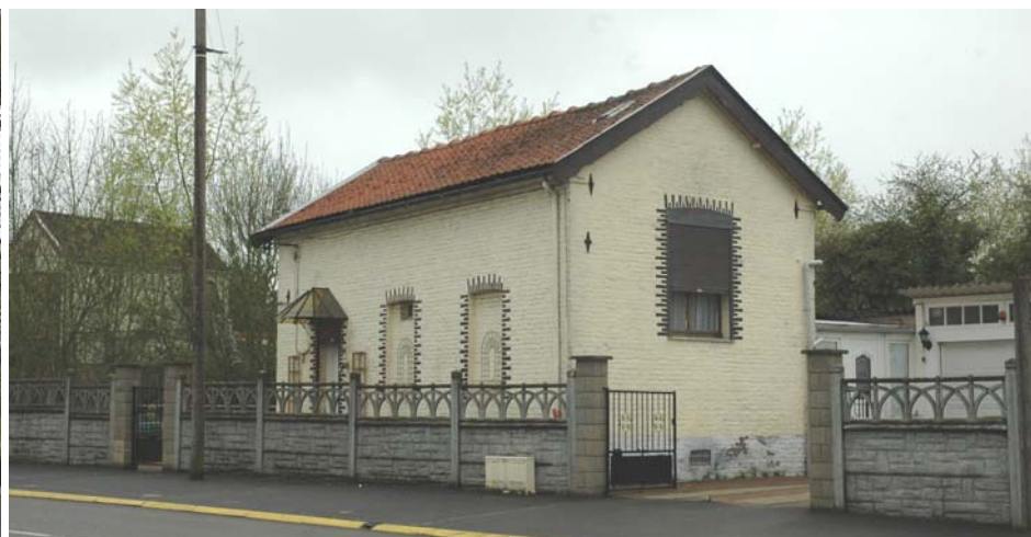
Maison de l'aiguilleur sur la voie ferrée Somain-Péruwelz ( D 954 à Fresnes)
