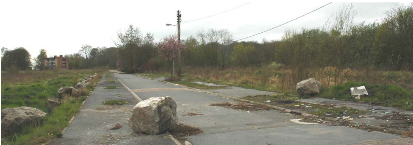
Emplacement des camus de la Cité des Hauts de Lorette à Condé
