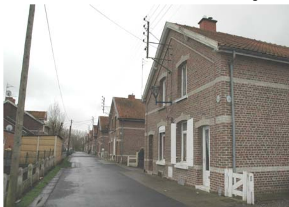
Cité pavillonnaire de la Verrerie
