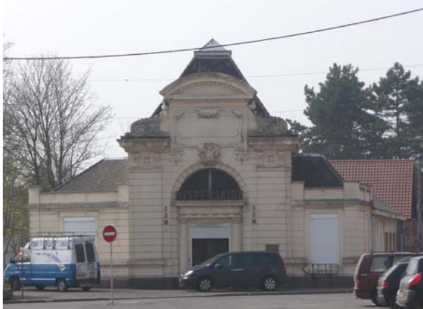
Dispensaire SSM 653 à Fresnes
