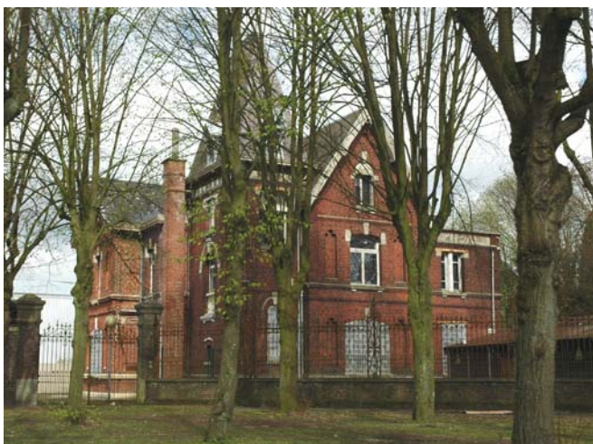
Maison d'ingénieur à proximité du Boulon
