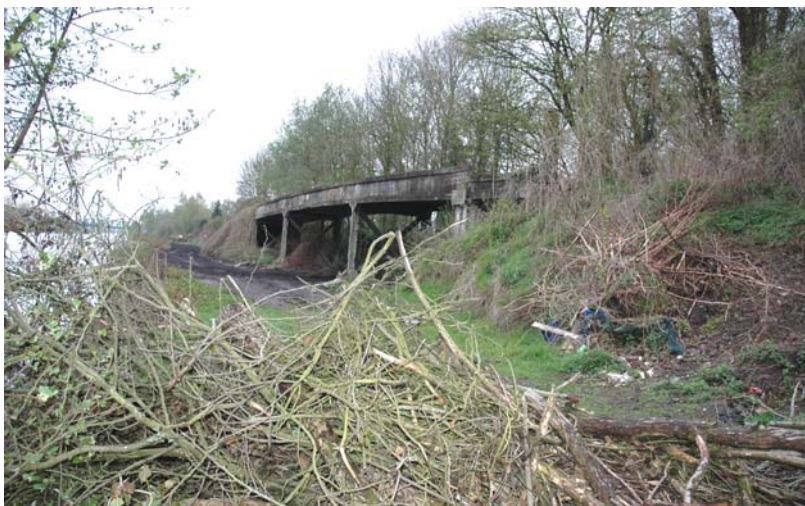
Pont ferroviaire au dessus du vieil Escaut à Fresnes
