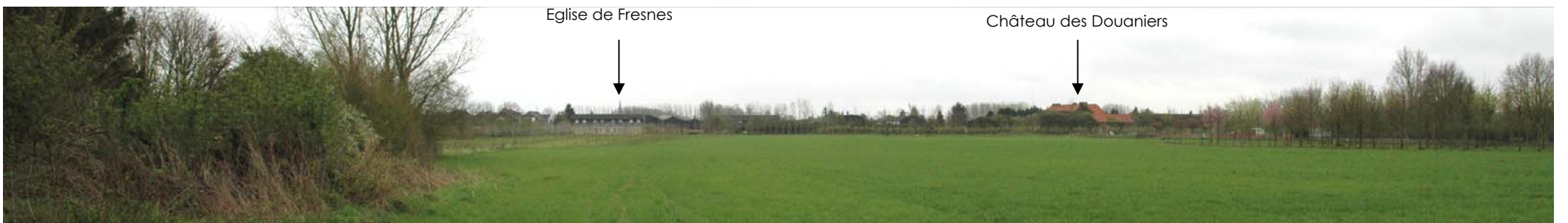
Vue sur le château des Douaniers et le clocher de Fresnes au niveau des arrières de la cité Hardy, à l'emplacement de l'ancienne Fosse des 4 Pagnons
