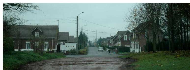
Mazingarbe, cheminée sud dans l'axe de la Rue Narcisse Houque.
