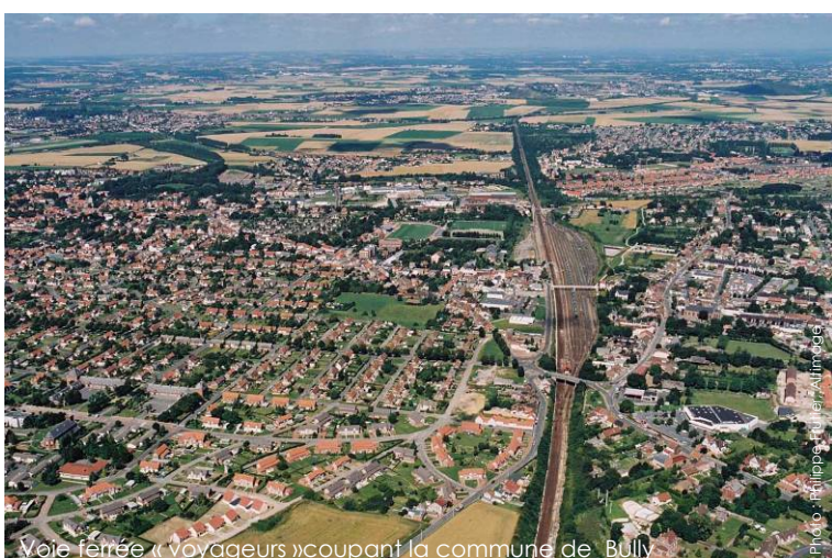
Voie ferrée « voyageurs » coupant la commune de Bully
