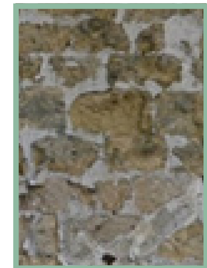
Moellons tendres de « second choix », début XX e ème, érodés en creux (même le joint en plâtre, pourtant fragile, a mieux résisté au temps)
