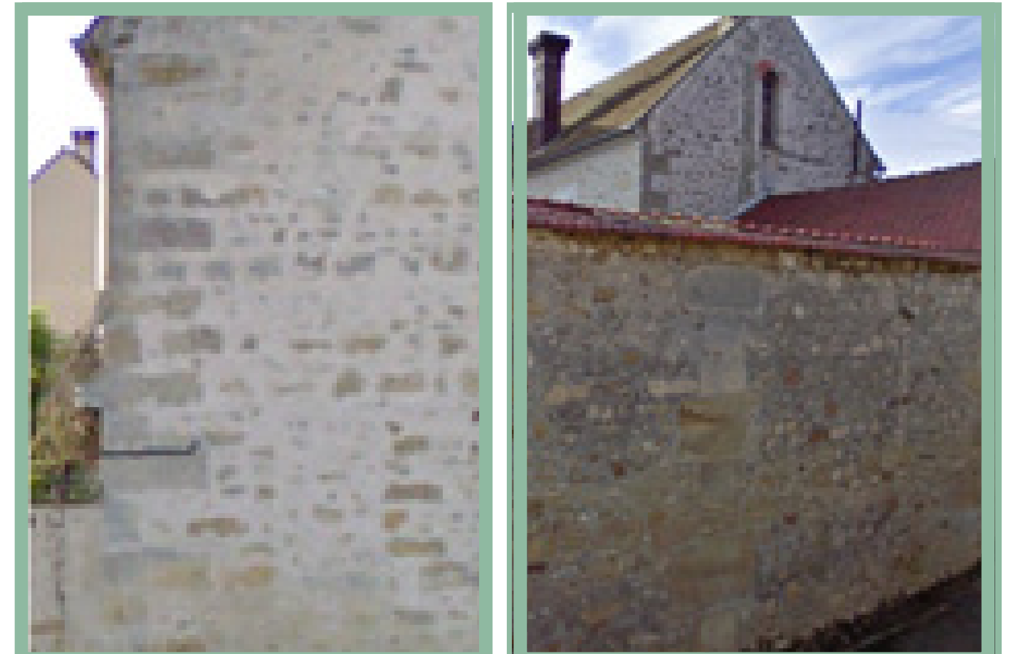
Mur de calcaire et meulière jointoyé au plâtre (traces de doigts) Façade de moellons calcaires enduits au plâtre et chaînages en pierre de taille
