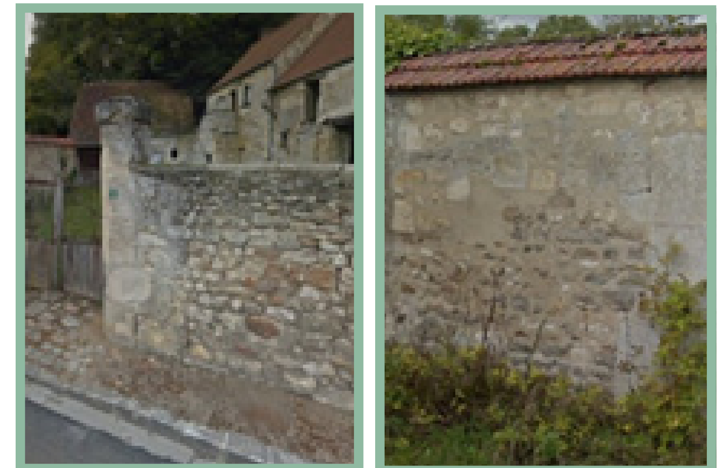
Bâtiments en grès et moellons (Theuville) Rhus : gros moellons et pierre de taille, joints largement beurrés chaux teinte beige-terre
