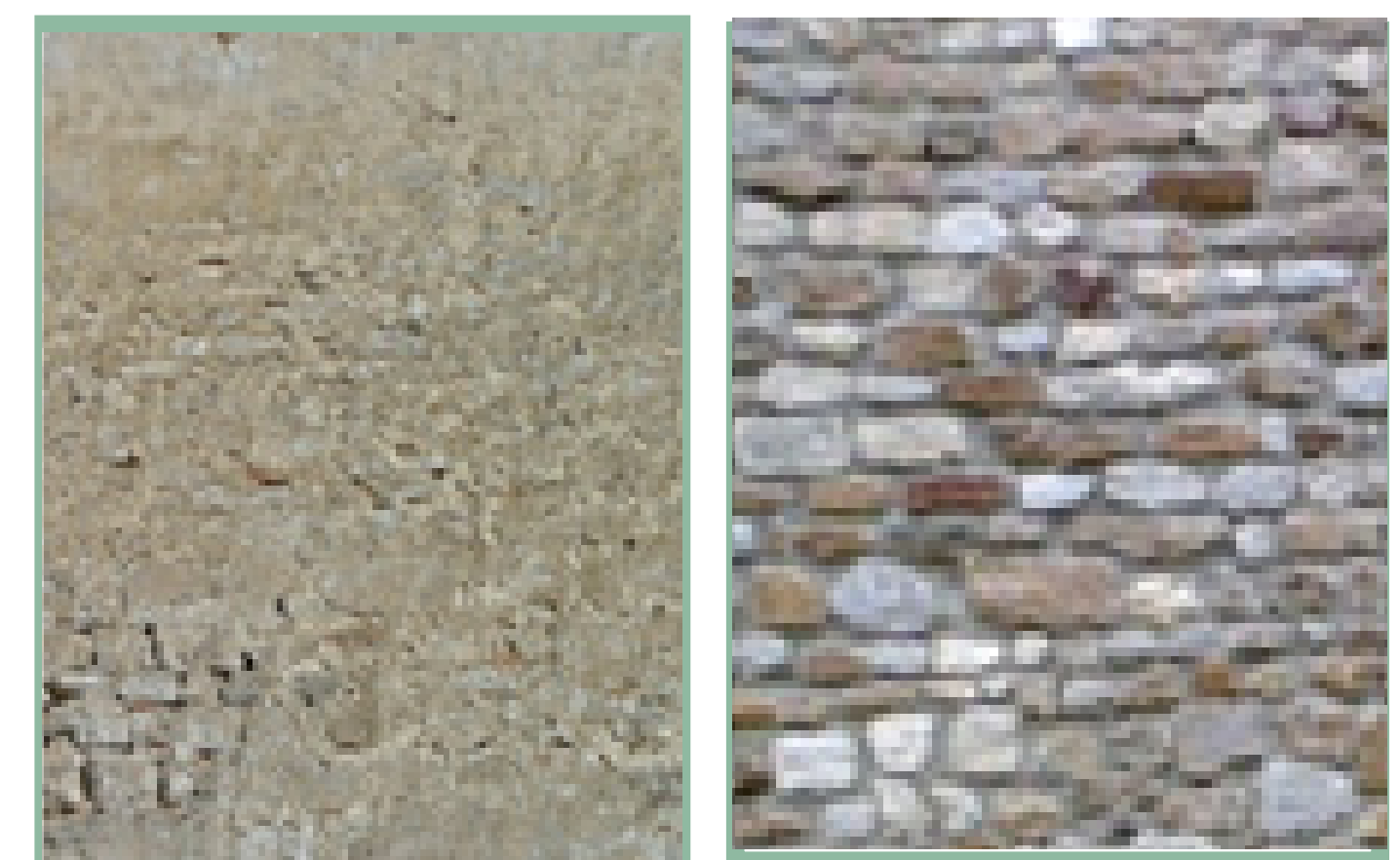
Moellons calcaires, enduit mince chaux-sable beige, Guiry-en-Vexin Mur en grès (Wy-dit-Joli-Village)
