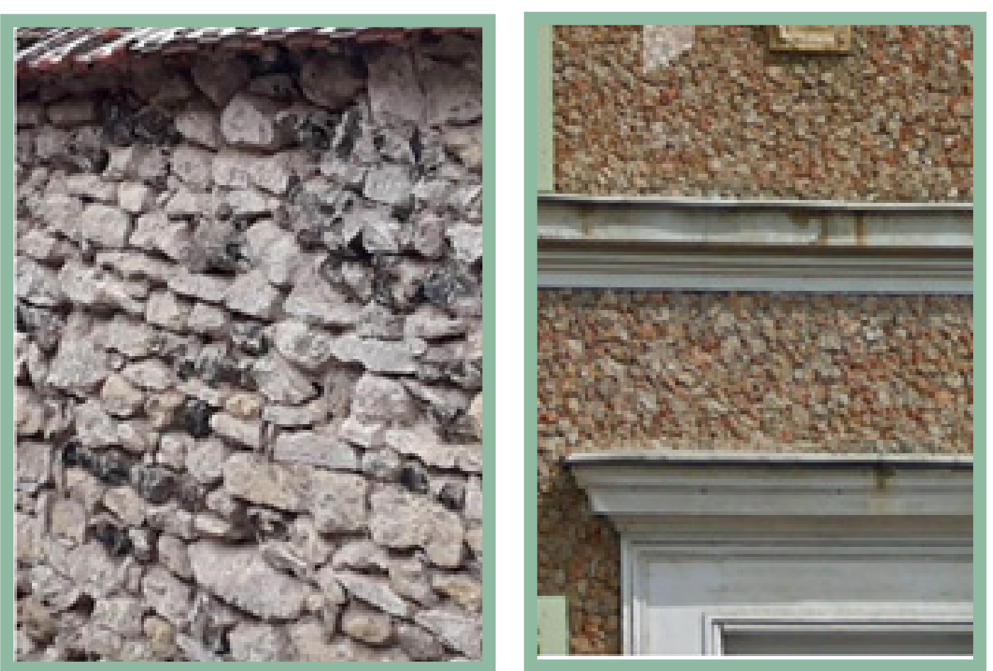
Les matériaux de la falaise ont été utilisés localement (silex grossièrement équarris à Haute-Isle) Façade de moellons calcaires enduits au plâtre et chaînages en pierre de taille
