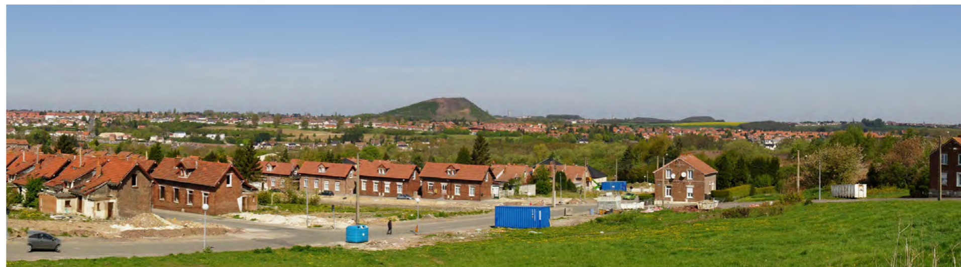
Cité n°6 en travaux et démolition à Colonne Ricouart
