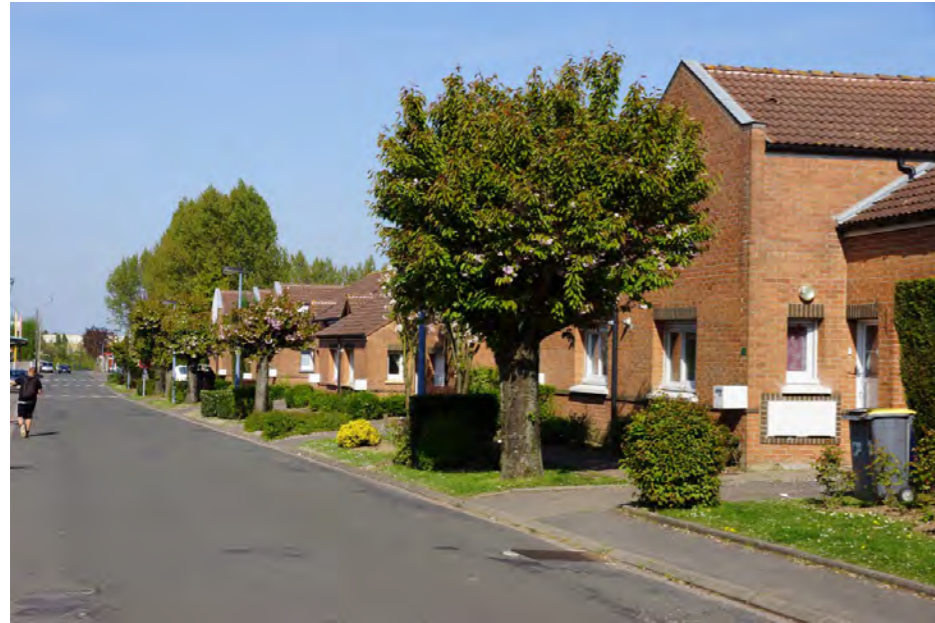
Constructions rue de Versailles à Barlin
