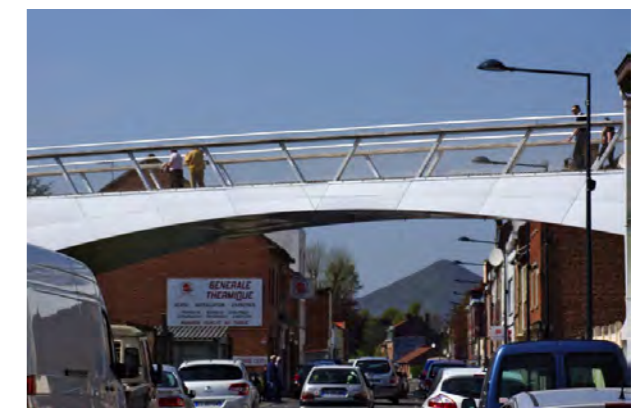
Ouvrage récent rétablissant la continuité d'un cavalier en direction du Louvre-Lens
