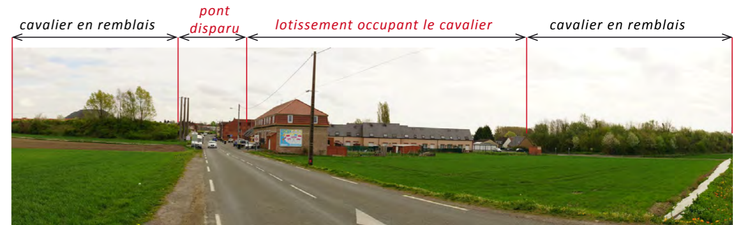
Double rupture de continuité sur un cavalier visible à Estevelles : l'ouvrage franchissant la route a été supprimé, et une section adjacente urbanisée en lotissement
