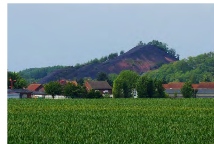
Le terril 157, au profil dissymétrique et qui présente les marques rouges de schistes brûlés, à Haveluy
