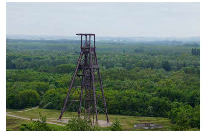
Vue en surplomb sur le chevalement de la fosse Ledoux, dominant les étendues boisées à Condé-sur-l'Escaut
