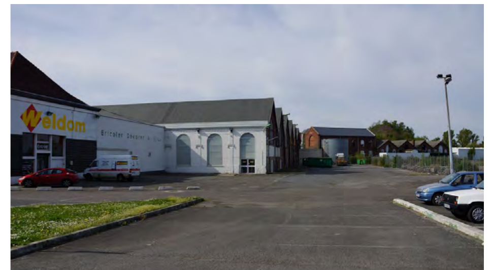
Fosse n°1 (au fond) et ateliers centraux (à gauche) à Nœux-les-Mines
