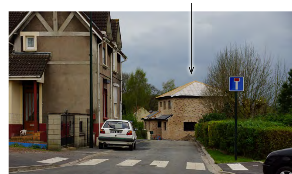
Construction sans cohérence avec la cité des Petits Bois, à Liévin
