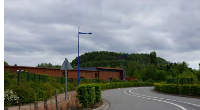
A Roost-Warendin, un bâtiment d'activité dont la couleur dense des façades, le soin apporté aux traitements de ses abords (limites privatives et espaces publics), le maintien d'une perception d'une part suffisante de la silhouette du terril (n°141), permet de préserver une vue de qualité sur ce dernier.
