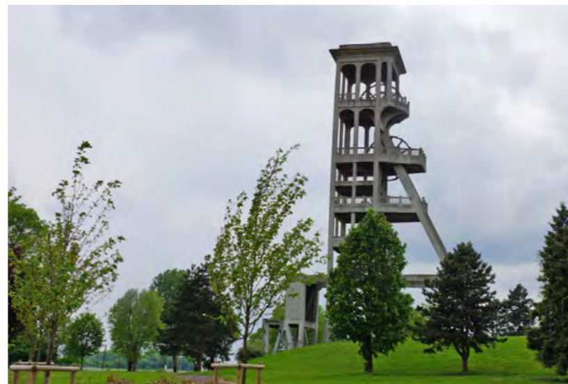
Le chevalement en béton armé du puits 2 de la fosse Dutemple à Valenciennes.
