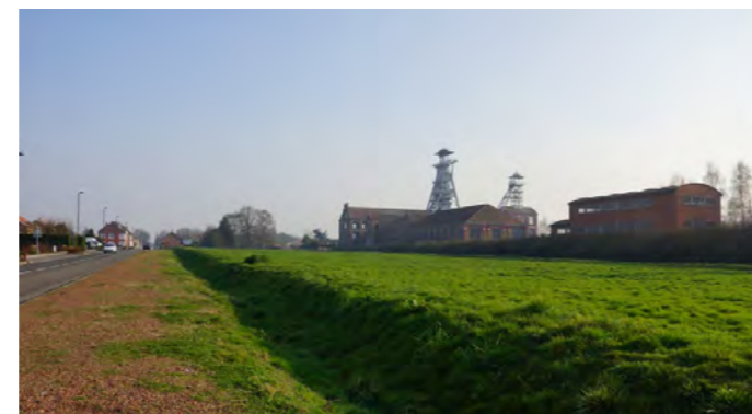
Petit « parvis » en herbe et à protéger, en avant de la fosse d'Arenberg et de la silhouette de ses chevalements.
