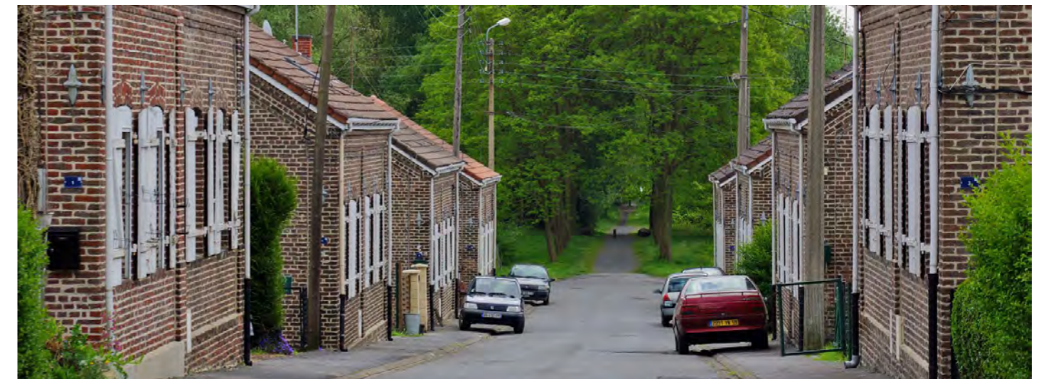
Exemple de continuité bien lisible, à la fois physique et visuelle, entre un quartier et un espace néo-naturel adjacent (connexion cité Lorette / étang de la Digue Noire à Condé-sur-l'Escaut)
