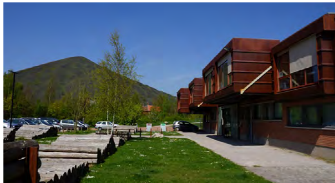
Sur le site de la fosse 11/19 à Loos-en-Gohelle, un bâtiment contemporain de hauteur modérée et positionné perpendiculairement (dans sa grande longueur) aux terrils jumeaux, un mode d'implantation qui permet de maintenir sur ses avants un large dégagement visuel sur l'un des deux terrils.
