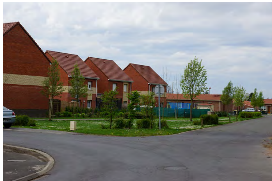
Construction reprenant des règles de cités en bordure de la cité de l'Hôpital à Fouquières-les-Lens
