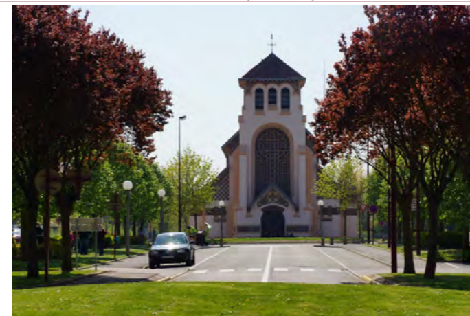
Eglise de la cité n°10 de Béthune à Sains-en-Gohelle
