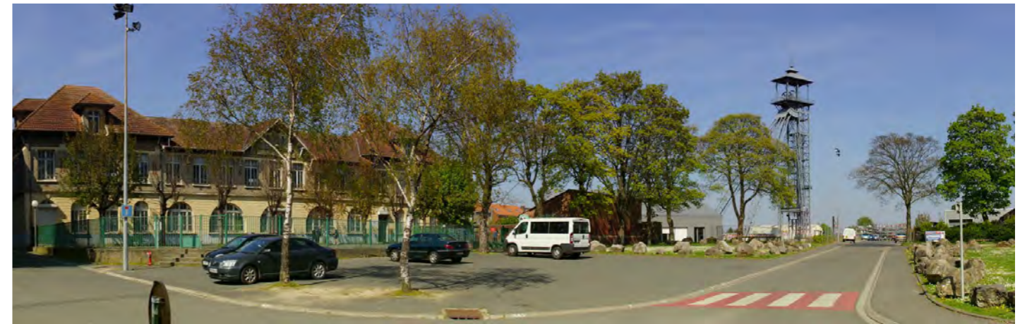
Vue sur le chevalement 3 de Lens (Saint Amé), depuis la place centrale de la Cité 3 à Liévin
