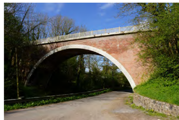
Ouvrage d'un cavalier franchissant un vallon à Divion
