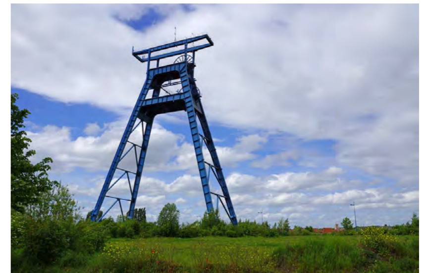
Le chevalement de la fosse 9 des mines de l'Escarpelle, à Roost-Warendin.
