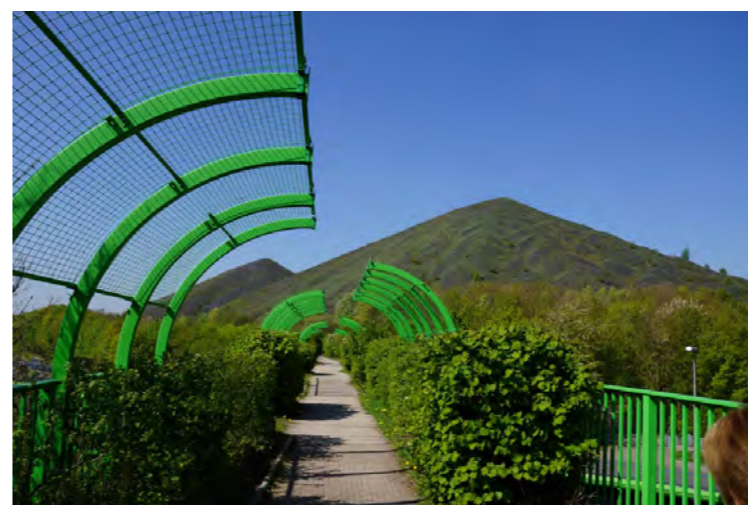
Passerelle franchissant l'A21 et donnant accès aux terrils 74 et 74a depuis la fosse n° 11/19 des mines de Lens, à Loos-en-Gohelle
