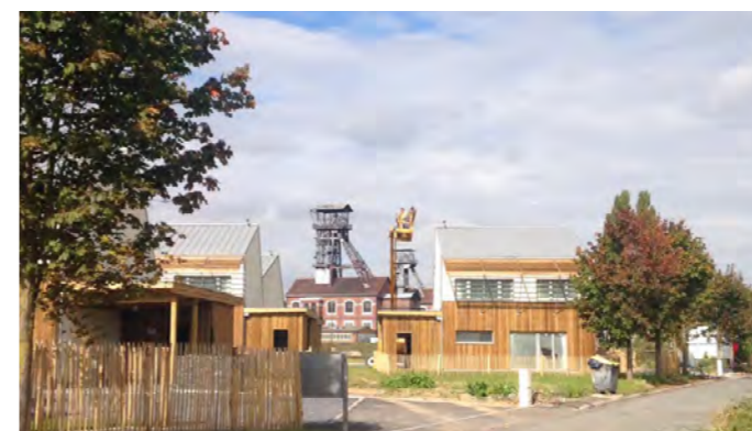
Dégagement visuel maintenu sur un chevalement, dans un nouveau front bâti (à Oignies).
