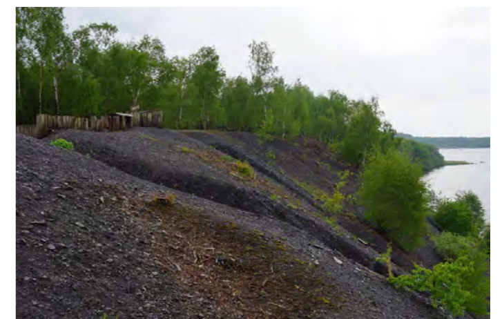
Ravinement de pentes par l'eau et le passage de piétons, en contrebas du belvédère sur la mare à Goriaux à Raismes et Wallers.
