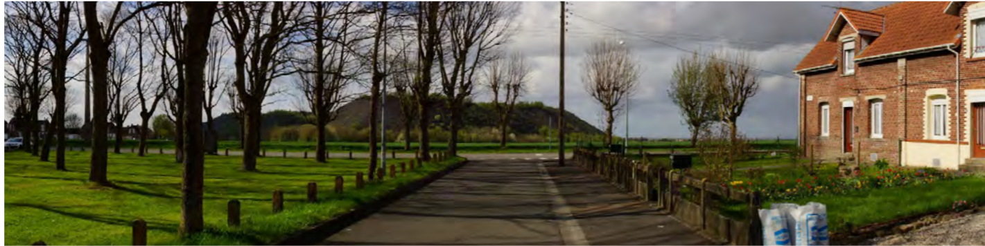
Le terril 58a face à la cité n°5 de Béthune (Grenay) : un vis-à-vis remarquable, dont la pérennité passe par la protection durable de l'espace agricole séparant la cité du terril.
