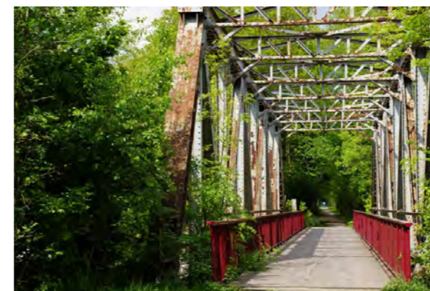
Ouvrage d'un cavalier à Condé-sur-l'Escaut, accessible aux piétons
