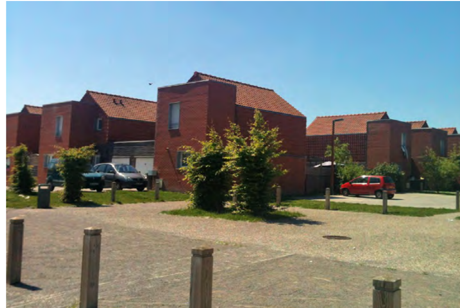
Constructions reprenant des règles de cités à Pecquencourt
