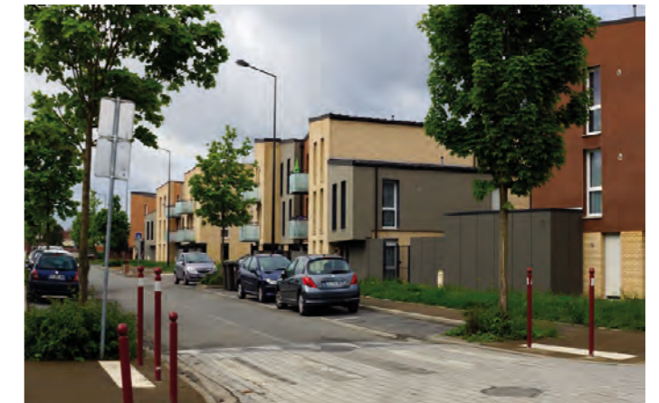
Escaudain - S'aligner sur rue : ici régulièrement par le mur pignon
