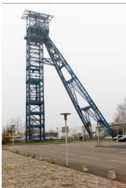
Dernier témoin des infrastructures de la fosse n°1 de Liévin, le **chevalement du puits n°1bis** de la Société Houillère de Liévin se situe au cœur d'une zone d'activité. Datant de 1922, il s'agit d'un chevalement à faux-carré porteur (type allemand) en poutrelles à treillis rivetés avec deux bigues également en poutrelles à treillis. Les molettes sont disposées de manière parallèle sur un palier avec garde-corps métalliques. Le chevalement est surmonté d'un campanile à quatre pans.
