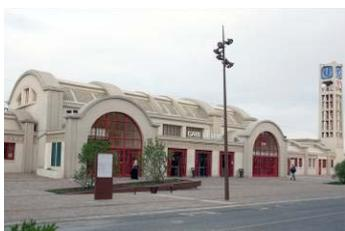
Edifiée sur un terrain minier, la gare est conçue pour résister aux affaissements du sous-sol. Le corps de la gare est ainsi constitué de 11 compartiments en béton armé non jointifs pouvant se mouvoir séparément. En sous-sol, il repose sur un cintre métallique qui, manœuvré par des vérins hydrauliques, permet de composer les mouvements de terrains.
