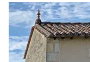
tuiles canal avec épis de faitage
