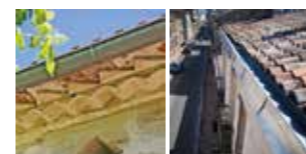
gouttière pendante chéneau encastré
