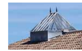
verrière sur une cage d'escalier
