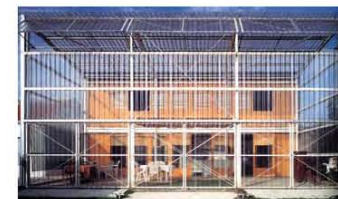
Matériau industriel - Lacton & Vassal Arch.
