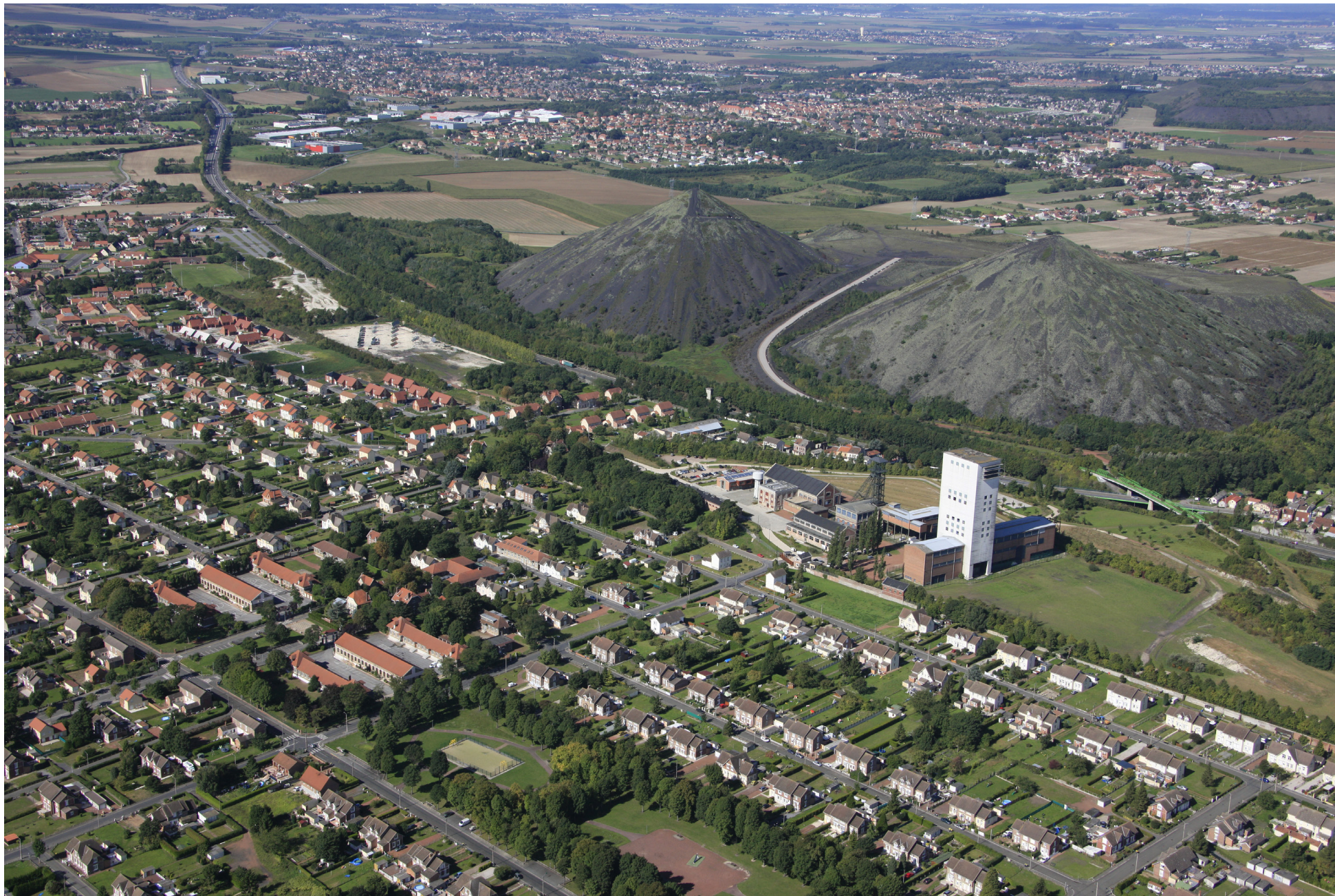
Vue aérienne de la Base du 11-19 bis à Loos-en-Gohelle
