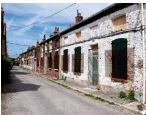
Vue générale, état actuel
