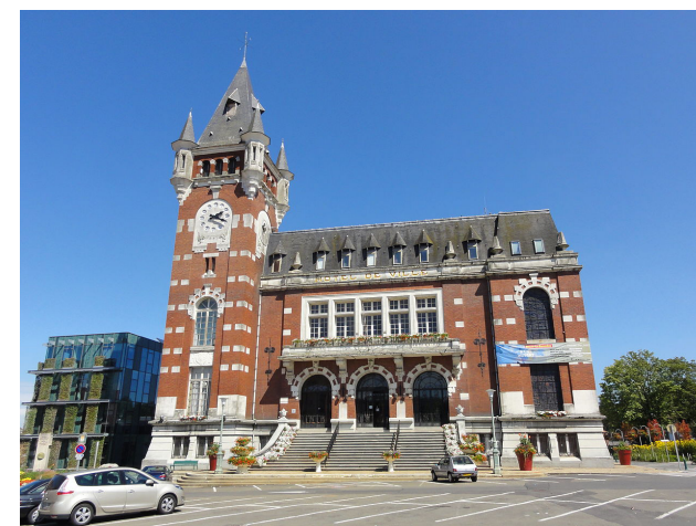
Valeur architecturale, urbaine et paysagère
