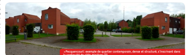
> Pecquencourt: exemple de quartier contemporain, dense et structuré, s'inscrivant dans la continuité de cités minières (3)
