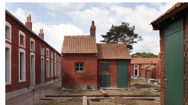
Cité des Électriciens à Bruay-La-Buissière - AAPP architectes
