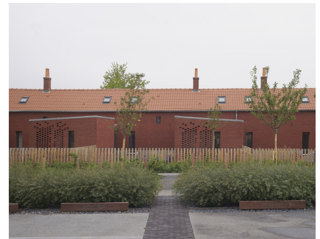
Extensions des coronas de la Cité des electriciens - BDAP architectes
