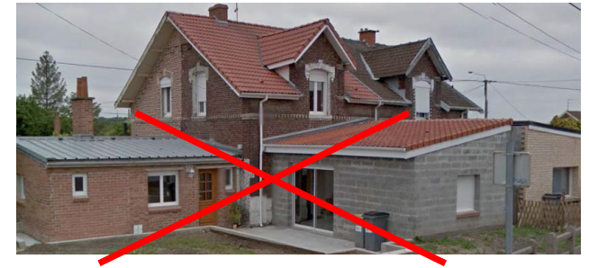
Exemple d'interventions qui dénaturent la cohérence et le caractère d'ensemble d'une cité.
