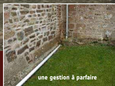
défauts d'étanchéité des solins
