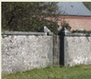
Mur de clôture traditionnel en pierre bleue
