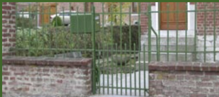
Boîte aux lettres intégré à la clôture
