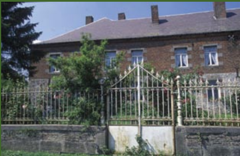
Eléments de transition traditionnels : muret en pierre bleue et grille en ferronnerie
