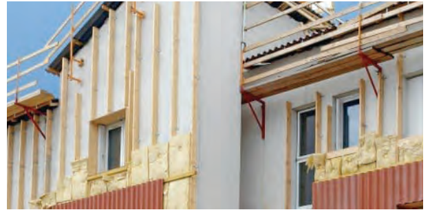
Accompagnement aux travaux d'ITE.
