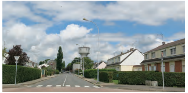
Château d'eau des quartiers de faubourgs Est d'Arras.
