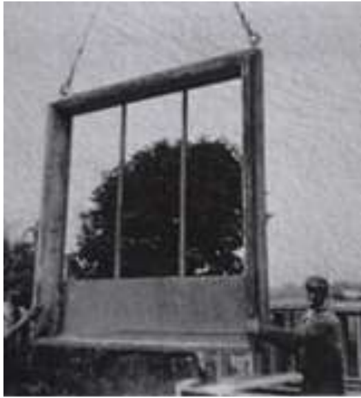
Le cadre de fenêtre en béton, élément préfabriqué pour un langage architectural commun
