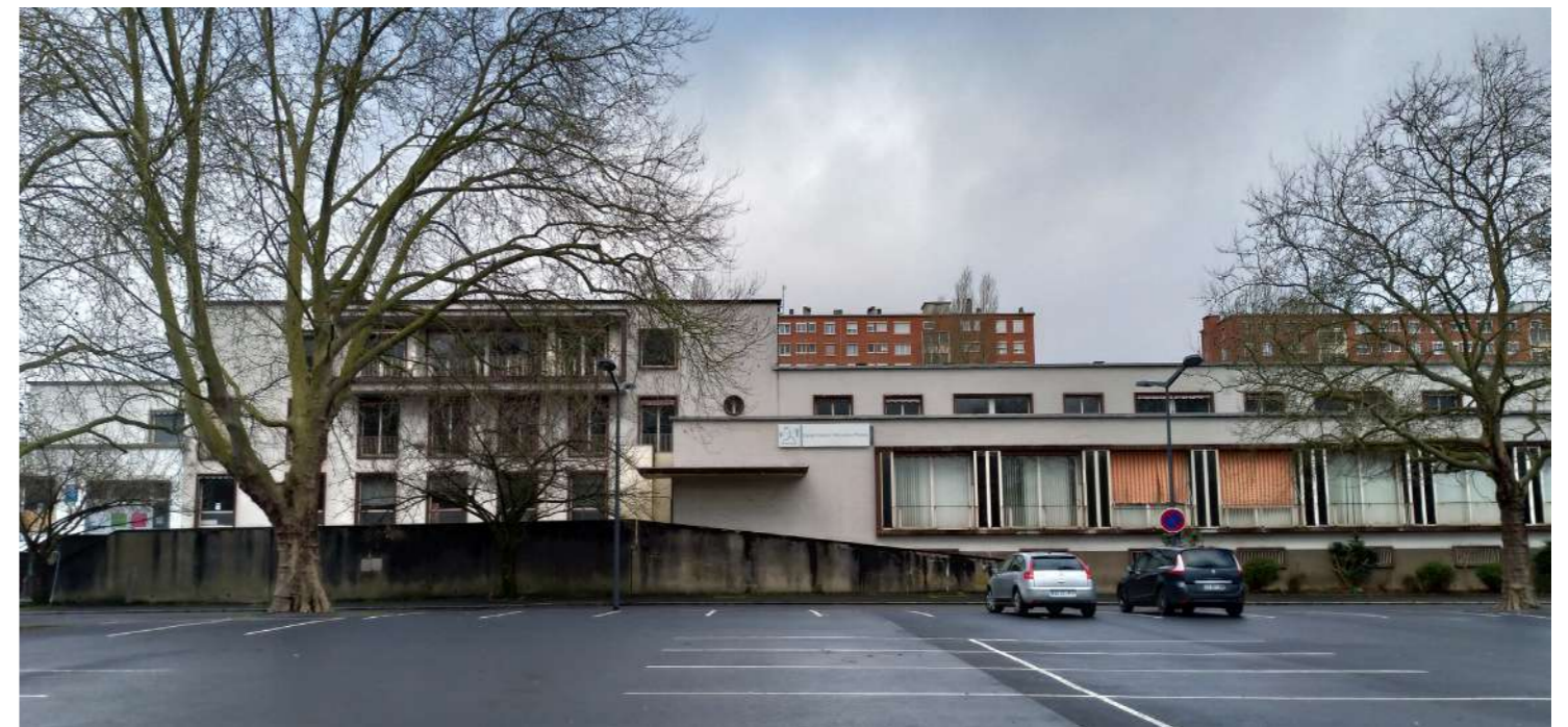
L'ancienne CAF, oeuvre d'André Lurçat, à l'ouest
