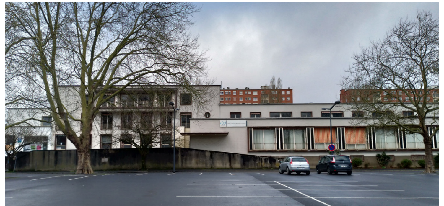
L'ancienne CAF, oeuvre d'André Lurçat, à l'ouest
