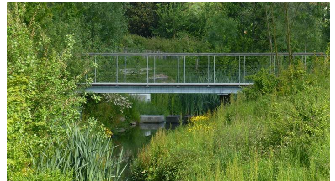
Intégration des passerelles dans le paysage
