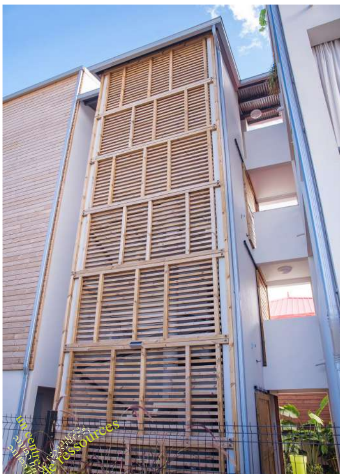
La cage d'escalier, volume dissocié.
