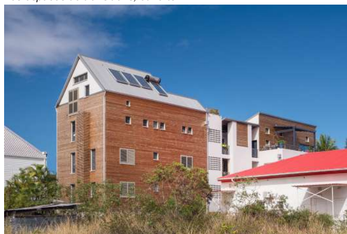
La façade arrière le long de la Chambre de Commerce, habillée de bois pour une meilleure isolation thermique.
