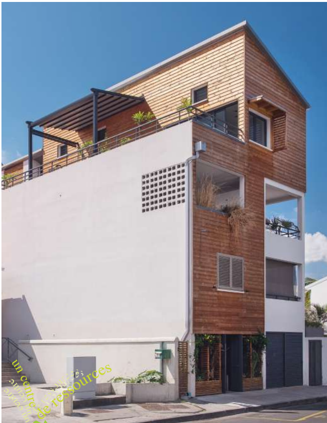
Positionnement des casquettes et joues selon l'orientation des baies.
