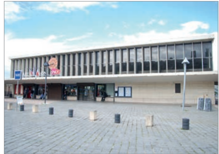
La gare SNCF de Laon témoigne d'une architecture typique des années 1950/60.
