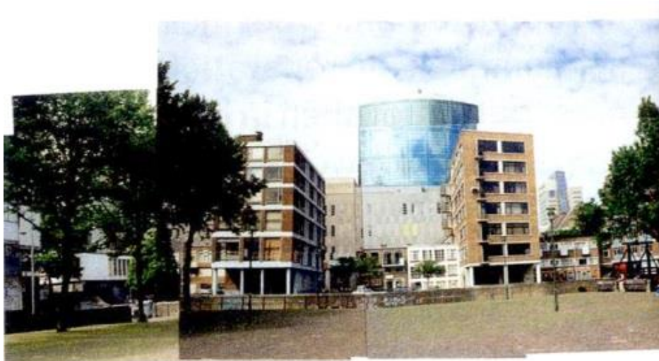
Figure 85, Exemple d'un ensemble hétérogène à Rotterdam. Heide Hinterthür observe la différence manifeste entre les bâtiments de l'arrière-plan dont la tour bleue-verte des années 1980, l'ensemble d'après-guerre avec les hautes constructions disposées à l'angle droit et les bâtiments bas du milieu. 350
