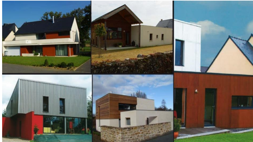
Figure 28, Exemples d'architectures extérieures données dans le CPAPE de la ZAC de la Grande Rangée sur la commune de Saint-Lambert-la-Potherie (Maine-et-Loire) 145
