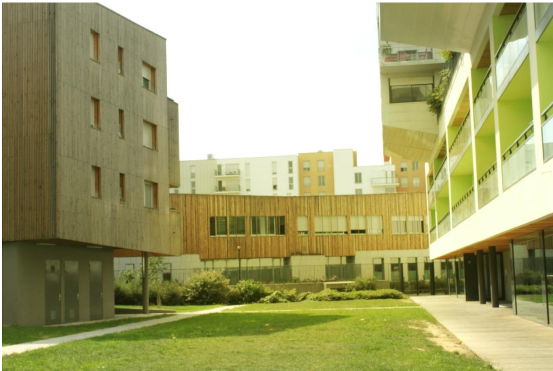
Figure 188, Effet de chaleur créé à l'intérieur du cœur d'îlot des logements Kanopé, rue du Cher. Il est ici dû à l'emploi de la couleur verte-jaune, la présence de la végétation et l'emploi du bois en façade. Photomontage réalisé d'après les photos des enquêtés et retravaillées sur le logiciel Adobe Photoshop® pour mieux représenter graphiquement les effets ressentis in situ par les enquêtés. Réalisation graphique: Anne Petit, 2014.
