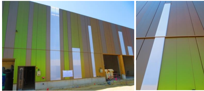
Figure 11, Changement de couleurs de la façade du vert-orange-violet-bleu lors du mouvement de l'observateur (acier pré-laqué changeant de la gamme Irysa, ArcelorMittal) usine d'eau à Plouharnel par l'architecte Stéphanie Fieve. 48
