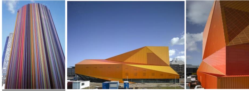
Figure 150, Exemples de déformation : à gauche, installation de Raymond Moretti, cheminée multicolore de l'esplanade de la défense, Paris 1989-1990 570 ; au centre et à droite, théâtre Agora, architecte Ben van Berkel, Lelystad (Holande), 2007 (exemple donné par Juan Serra Lluch pour illustrer l'illusion d'une géométrie) 571 .
