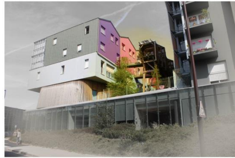
Rue Célestin Freneit, Logements Playtime: effet d'appel visuel, façades et forme architecturale intrigante
